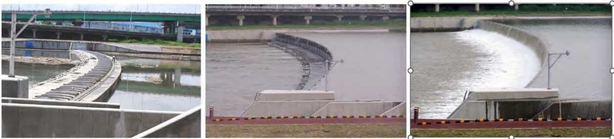
Abbildung 29: Beispiel eines gekrümmten Obermeyer-Wehrs. Die Geometrie des Wehrtischs ist abweichend zur vorliegenden Planung, Quelle: Dyrhoff Ltd. (Quelle: IB Fichtner 2024, S. 46)
