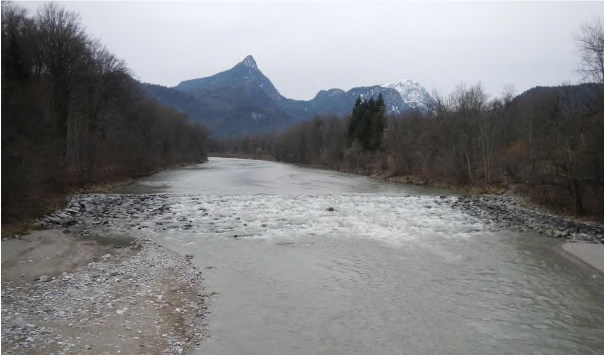
Abbildung 32: Foto Bestand Nonner Rampe vom Nonner Steg aus (17.3.2015, 11:00 Uhr, Abfluss ca. 21,3 m 3 /s, Pegel Unterjettenberg und damit mittig zwischen MNQ von 9,13 m 3 /s und MQ 38,2 m 3 /s)
