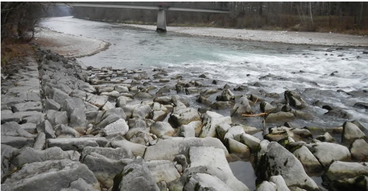
Abbildung 38: oberes Ende Nonner Rampe mit massiver Uferscherung vom linken Ufer, Blickrichtung nach Unterstrom zum Nonner Steg (04.12.2016)
