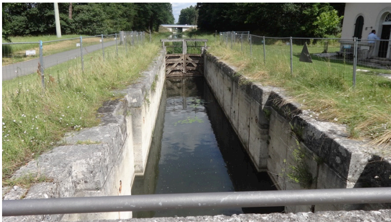
Abb. 26: Unbenutztes Schleusenbauwerk in BA3
