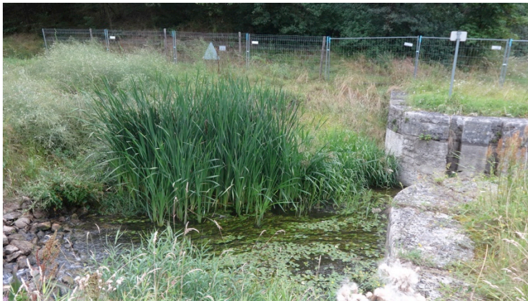
Abb. 27: Großröhricht im Schleusenbereich in BA3
