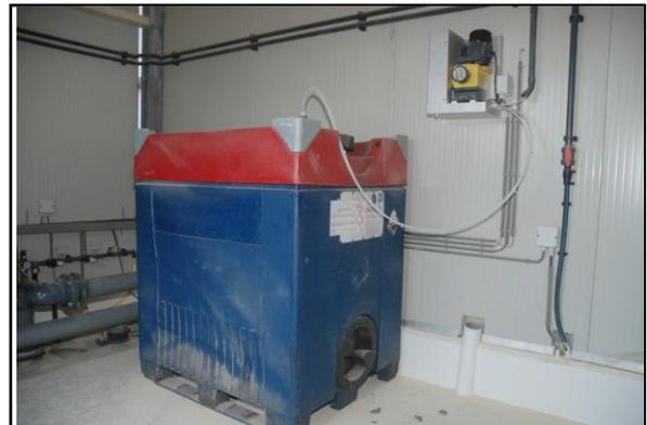
Abbildung 3: Säurepumpe (links) und Schwefelsäuretank (rechts)
