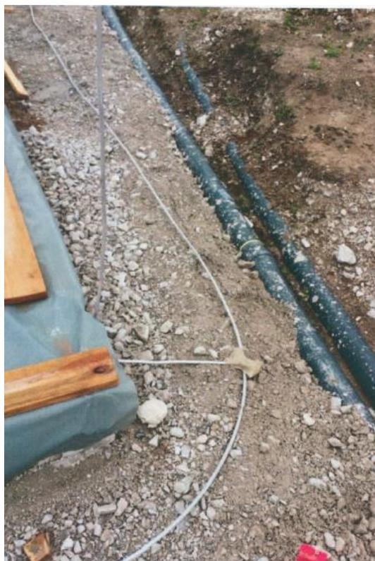
Abbildung 7 UW Finkenbrunn Erdungseinrichtung
