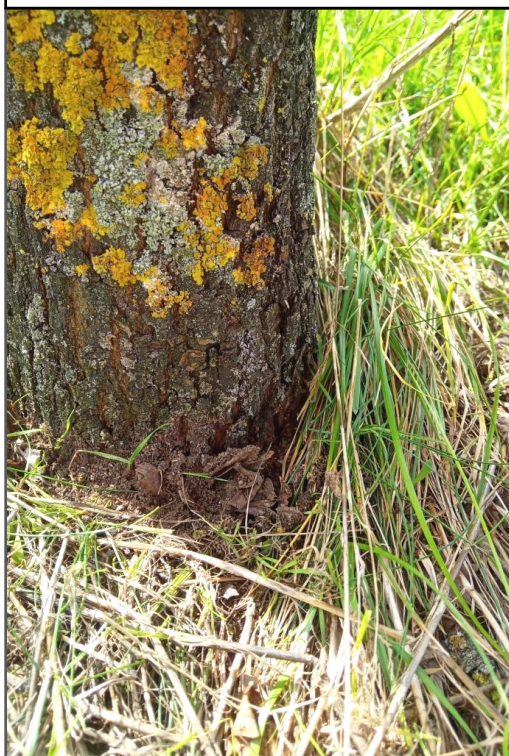
Abb. 7.3-65: keine Schäden am Stammfuß
