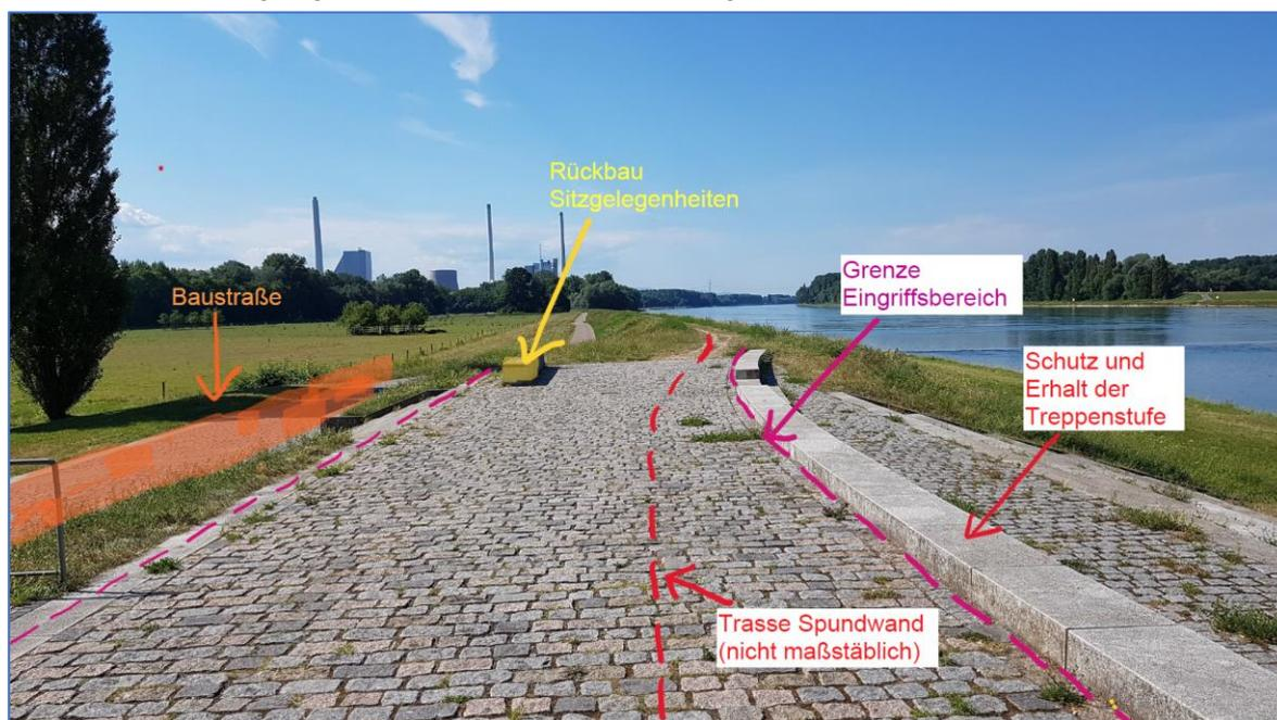
**Abbildung 8:** Skizzierung der geplanten Baumaßnahmen und des Eingriffsbereichs im Abschnitt der Rheinterrassen am Hofgut Maxau (Quelle: Anlage 2.1 zum Planfeststellungsantrag)
