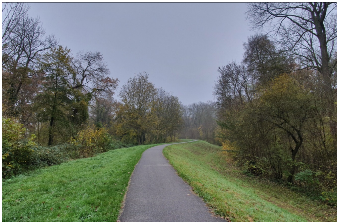
Abbildung 107: RHW XXXIX im Norden des Abschnitts 3, Blick nach Süden
