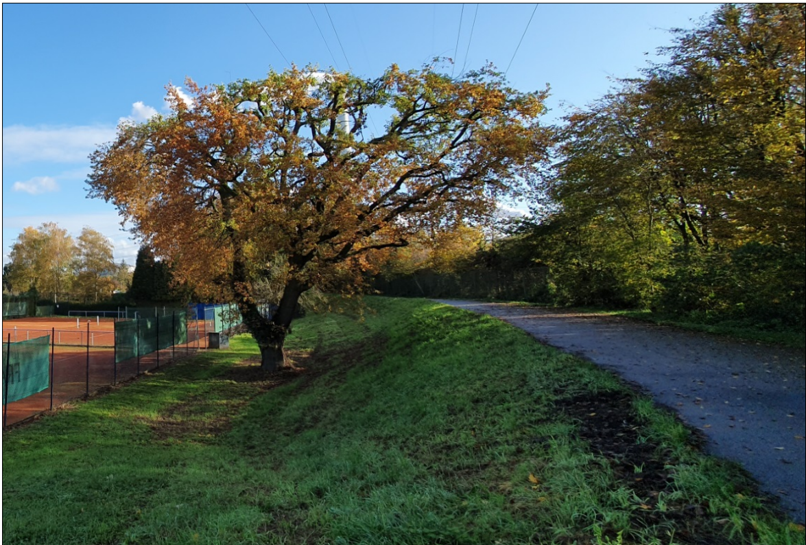
Abbildung 101: RHWD XXXIX im Bereich Abschnitt 1 auf Höhe der Tennisanlage des VfL Kurpfalz Mannheim-Neckarau e.V., Blick nach Osten
