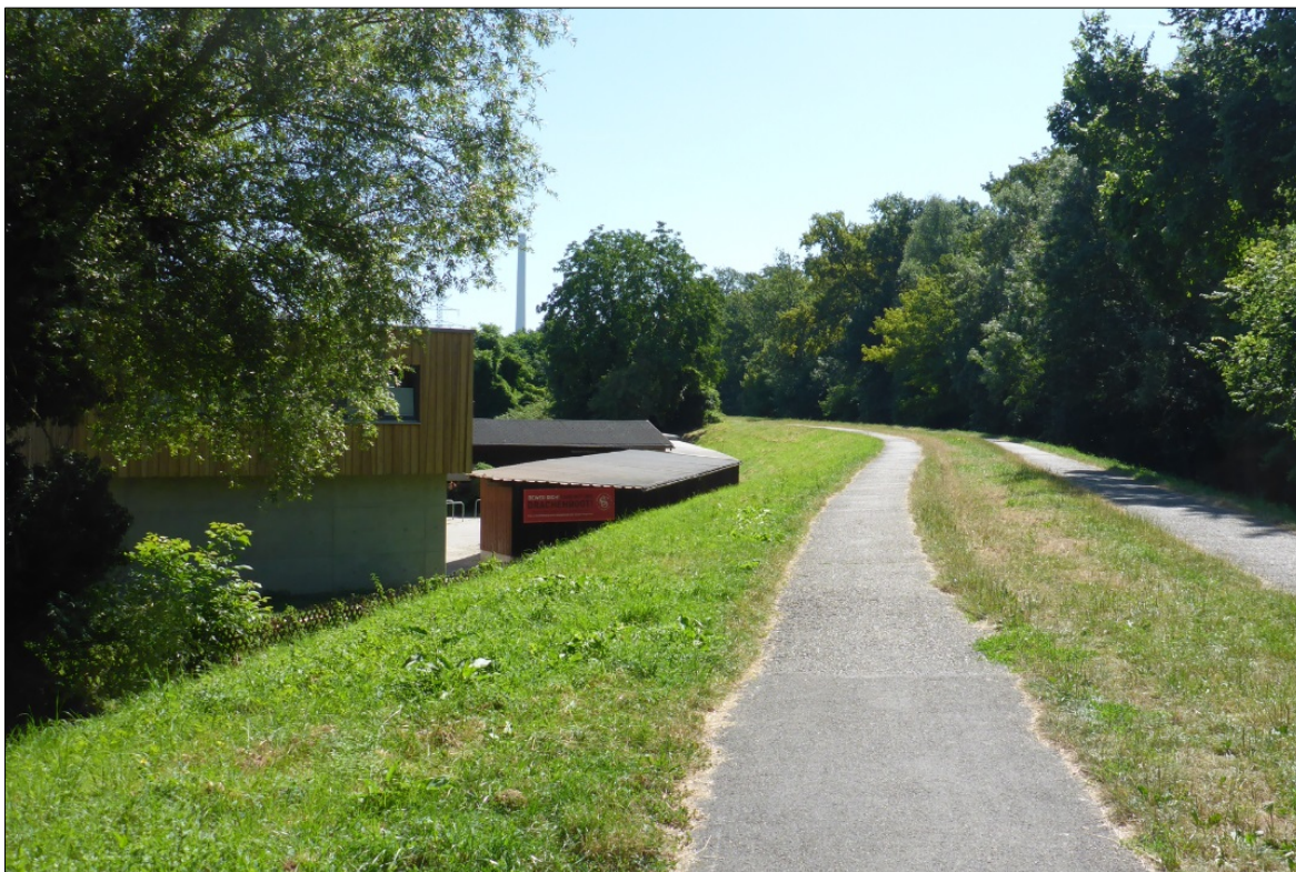
Abbildung 151: Bootsschuppen des Kanu-Sport-Clubs e.V.), die im Zuge der Dammsanierung entfernt und an anderer Stelle wieder neu errichtet werden
