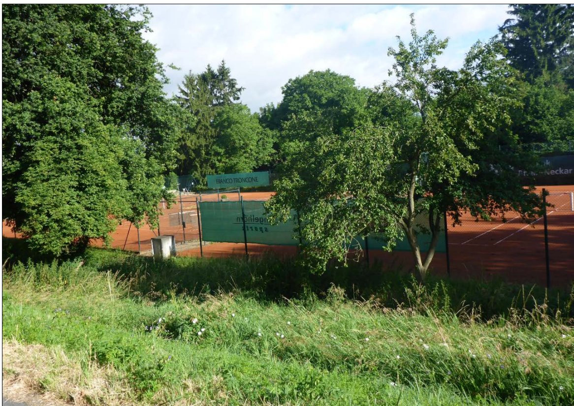
Abbildung 137: Blick von der Dammkrone bei ca. Damm-km 0+170 auf die Tennisanlagen des VfL Kurpfalz Mannheim-Neckarau e.V.
