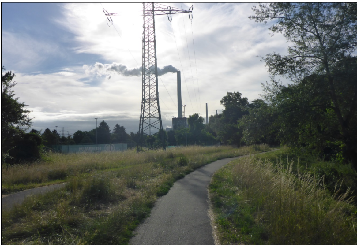
Abbildung 103: RHWD XXXIX im Osten des Abschnitts 2 im Übergang zu Abschnitt 1, im Hintergrund die Anlagen des GKM, Blick nach Osten
