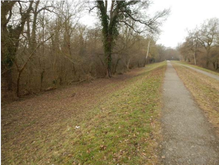
Bild 17: Bestands-km ca. 1+150 – Blick in Fließrichtung
