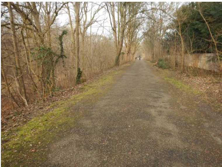
Bild 36: Bestands-km ca. 3+100 – Blick in Fließrichtung
