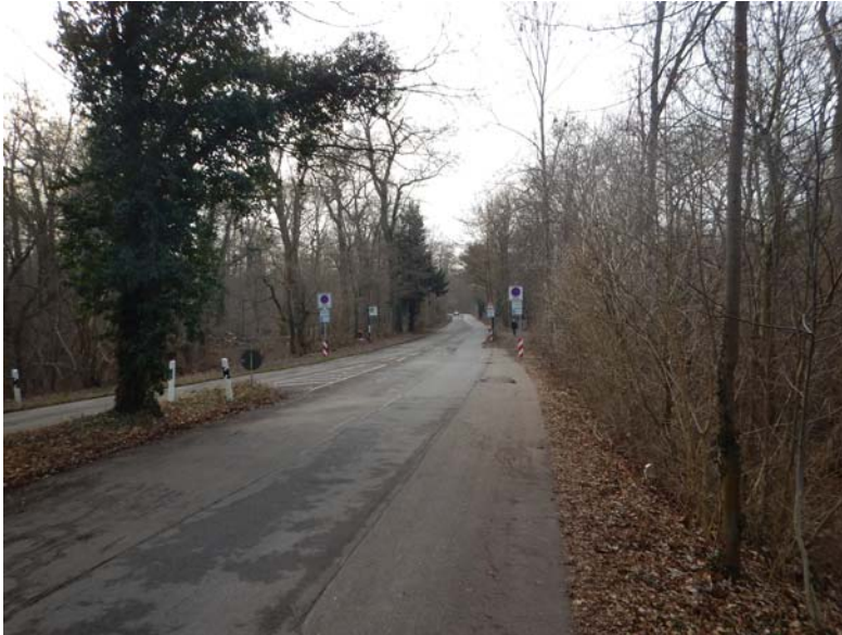
Bild 25: Bestands-km ca. 1+900 – Blick gegen Fließrichtung (wasserseitig)
