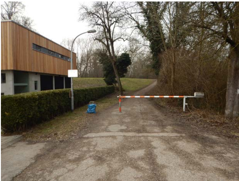
Bild 20: Bestands-km ca. 1+250 – Blick in Fließrichtung auf Dammkörper
