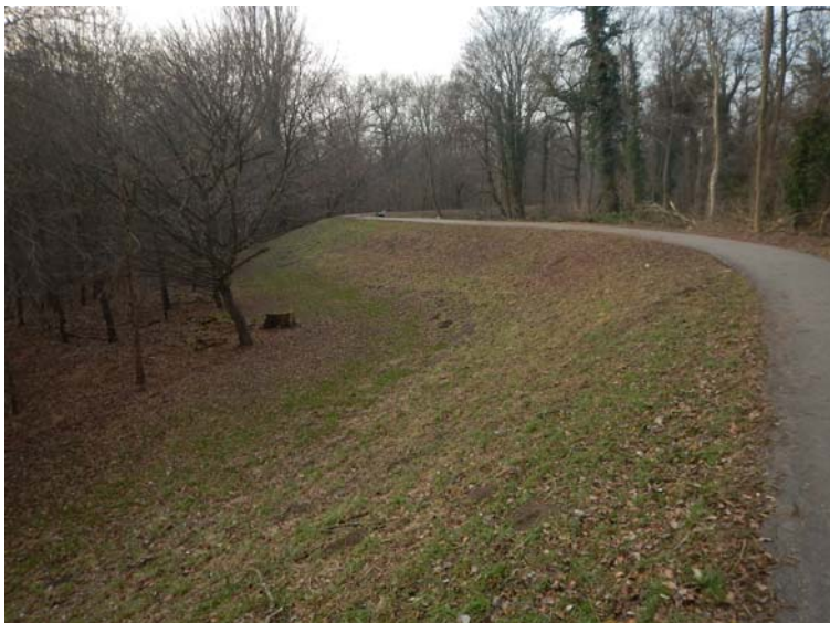
Bild 22: Bestands-km ca. 1+400 – Blick in Fließrichtung
