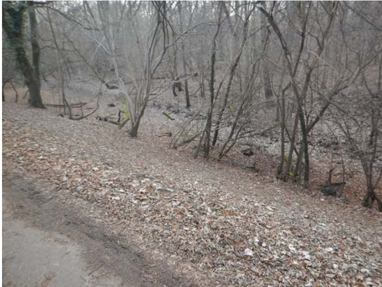
Bild 29: Bestands-km ca. 2+050 – Blick gegen Fließrichtung (wasserseitig)
