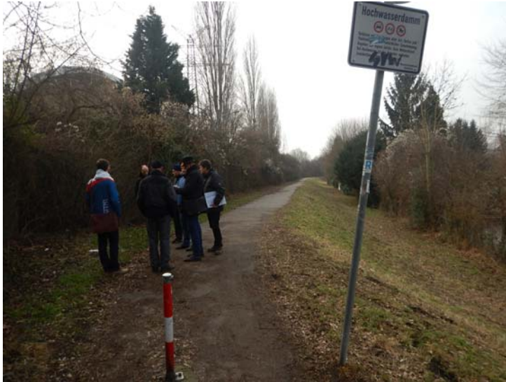
Bild 1: Bestands-km ca. 0+000 – Blick in Fließrichtung
