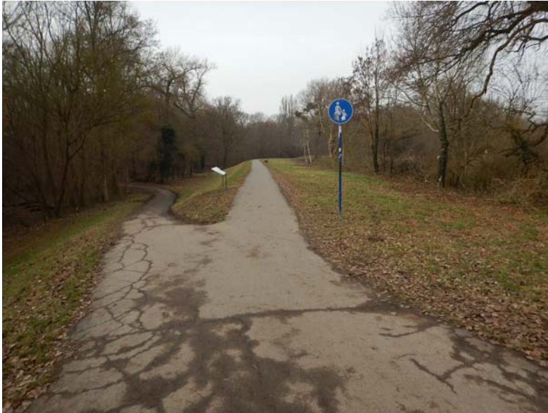
Bild 19: Bestands-km ca. 1+250 – Blick in Fließrichtung
