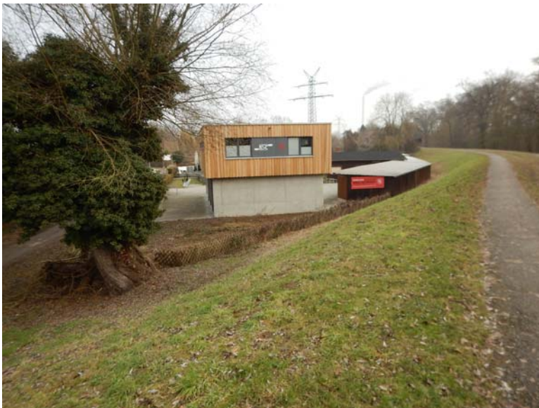
Bild 18: Bestands-km ca. 1+250 – Blick gegen Fließrichtung
