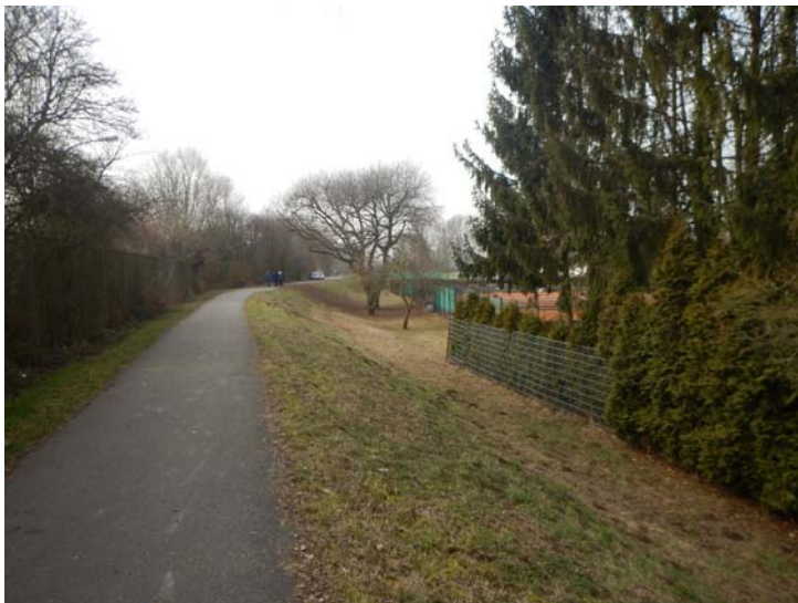
Bild 2: Bestands-km ca. 0+150 – Blick in Fließrichtung
