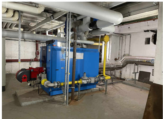
Übersicht Heizkeller, Beton- Bodenplatte u. - Stützen, Decke aus Stahlträgern mit Beton-Kappendecke
