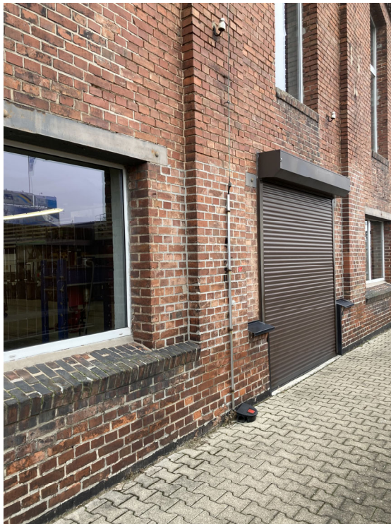
Südansicht - Fassadeneingriffe: Kunststofffenster, Stahlträgerstürze, Rolltor, Reparaturbereich überputzte Fassadenfläche
