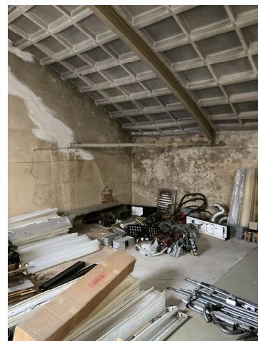
3 OG, Kassettendecke, tlw. provisorisch unterstützt, höhergelegtes horizontales Stahlzugband
