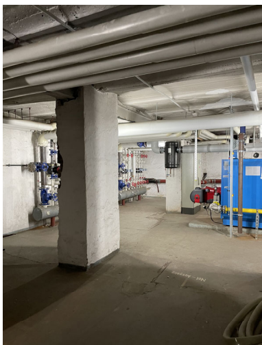
Übersicht Heizkeller, Beton- Bodenplatte u. - Stützen, Decke aus Stahlträgern mit Beton-Kappendecke
