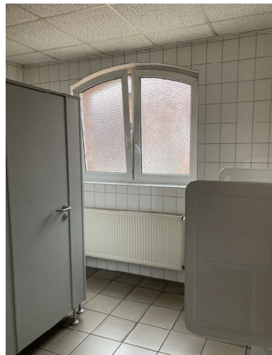
WC-Anlagen, Bodenfliesen, Wandfliesen raumhoch, abgehängte OWA-Decke, Kunststofffenster mit Isolierverglasung
