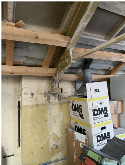
3 OG, Kassettendecke, tlw. provisorisch unterstützt, höhergelegtes horizontales Stahlzugband
