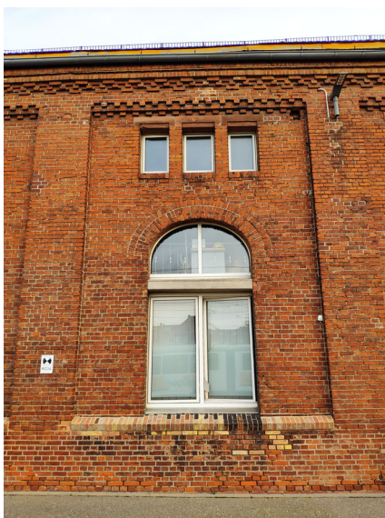
Fassadeneingriffe: Betondecke, Reparatur Fensterbank, Kunststofffenster
