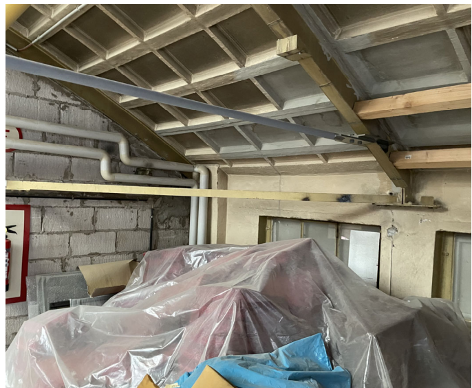
3 OG, Kassettendecke, tlw. provisorisch unterstützt, höhergelegtes horizontales Stahlzugband
