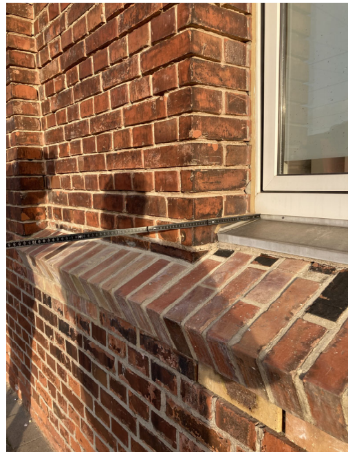
Klinkermauerwerk im Blockverband, Rollschicht als Fensterbank, diverse Ausbesserungen
