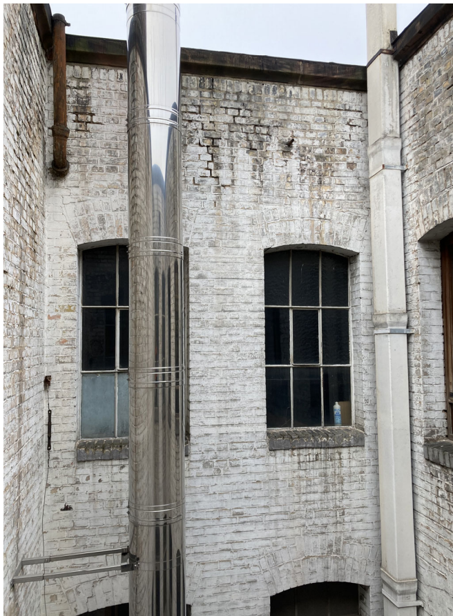
Lichthof Segmentbogenfenster, Stahl 1-fach verglast Dachrandabschluss mit Sandsteinwerkstücken
