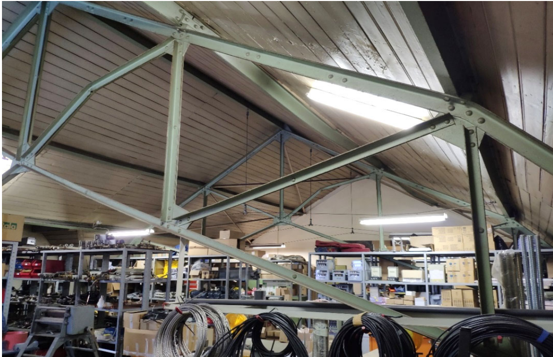
Dachtragwerk, Stahlbinder, teilweise beschädigt, Brettschalung
