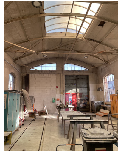
frühere Hallentoröffnung links wandbündig zugemauert
