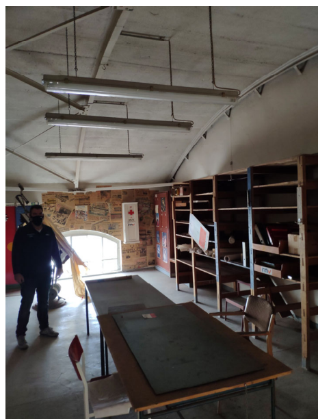
Nachträglich eingezogene Zwischenebene, Nutzung als Pausenraum, Anpassungen der ursprünglichen Segmentbogenfensterelemente
