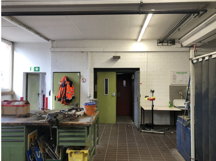
Nebenausgang (Zugang Fahrzeughalle) Aufzug von EG-DG brandschutztechnische Trennung zur Fahrzeughalle und der Geschosse nicht vorhanden.
