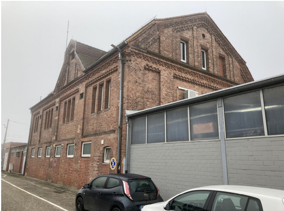
Grenzwand, Nord-Ostecke - Dachkonstruktion Mansarddach, Stahltragwerk mit einem eingeschobenen Zwerchgiebel auf der Gebäudeostseite
