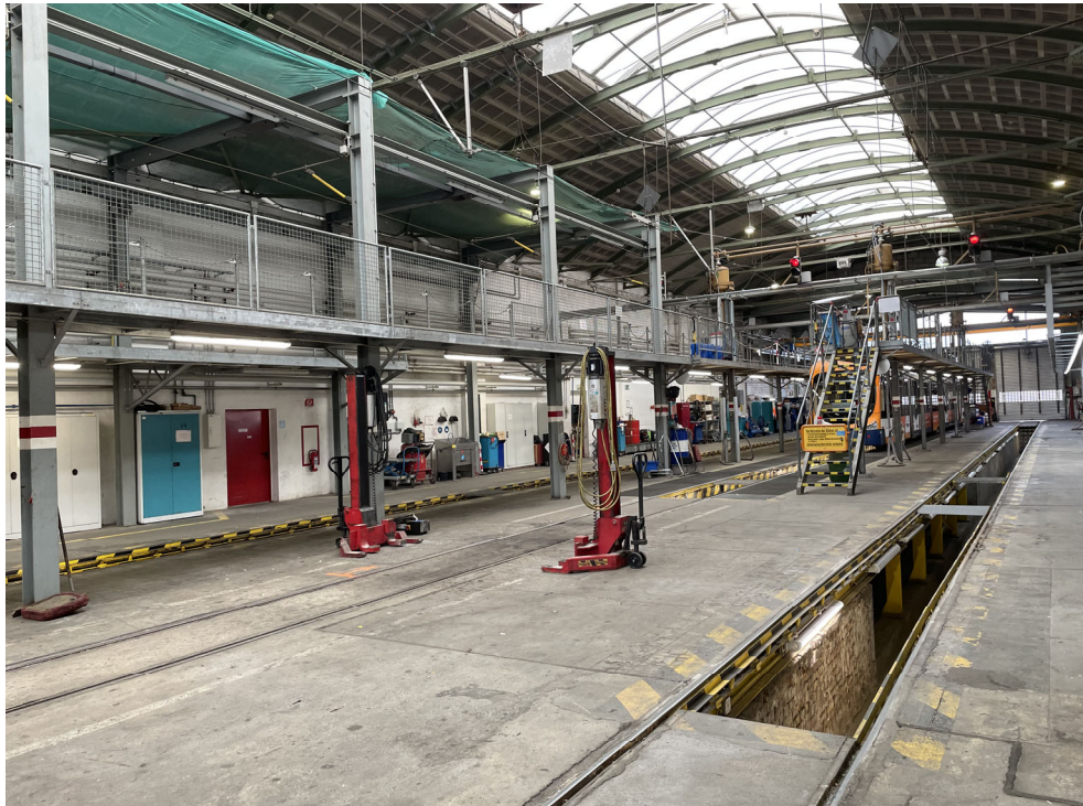
2 Halle 2 - Beton-Kassettendecke, Bogenträger mit horizontalem Stahlwinkel-Zugband, Wartungsgruben, Betonboden mit div. Gitterrosteinlagen, Wartungsbühnen Oberlichtband in Alukonstruktion mit halbtransparenter Kunststoffverglasung
