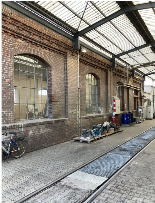
regelmäßige nachträglich hergestellte Auflagerpunkte für Überdachung Werkstraße
