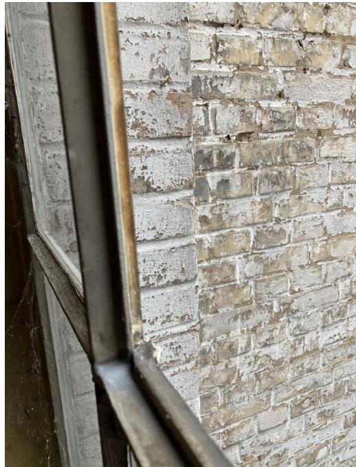
T-Stahlprofile, 1-Scheibenverglasung gekittet
