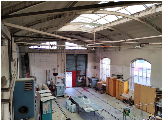
Übersicht Lackiererei - Bogenhalle, Dachtragwerk besteh. aus Betondecke, Bogenträger mit horizontalem Stahlwinkel-Zugband, Oberlichtband in Alukonstruktion mit halbdtransparenter Kunststoffverglasung
