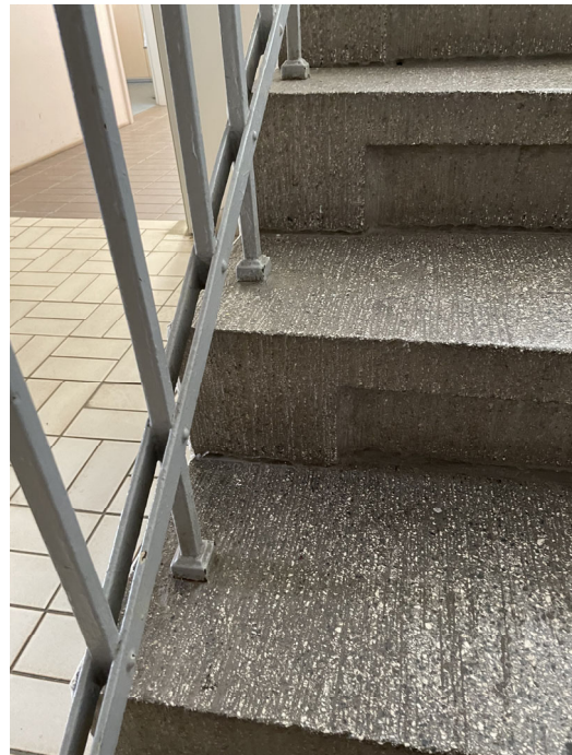
Zugang zu 1. OG, Beton-Werksteinstufen, Metallgeländer mit Holzhandlauf
