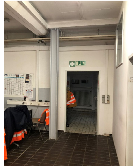
Stützkonstruktion Betondecke
