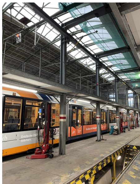
Wartungsbühnen und Wartungsgruben mit seith. Gitterrosteinlagen, Treppenaufgang zu Bühne
