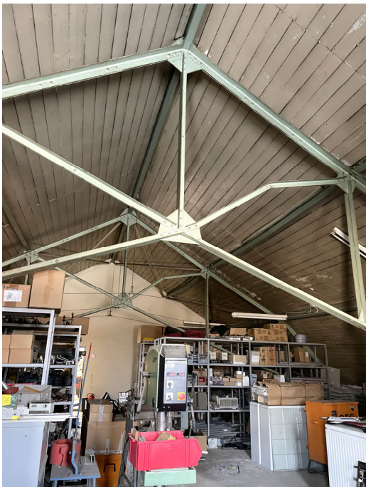
beschädigter Dachbinder
