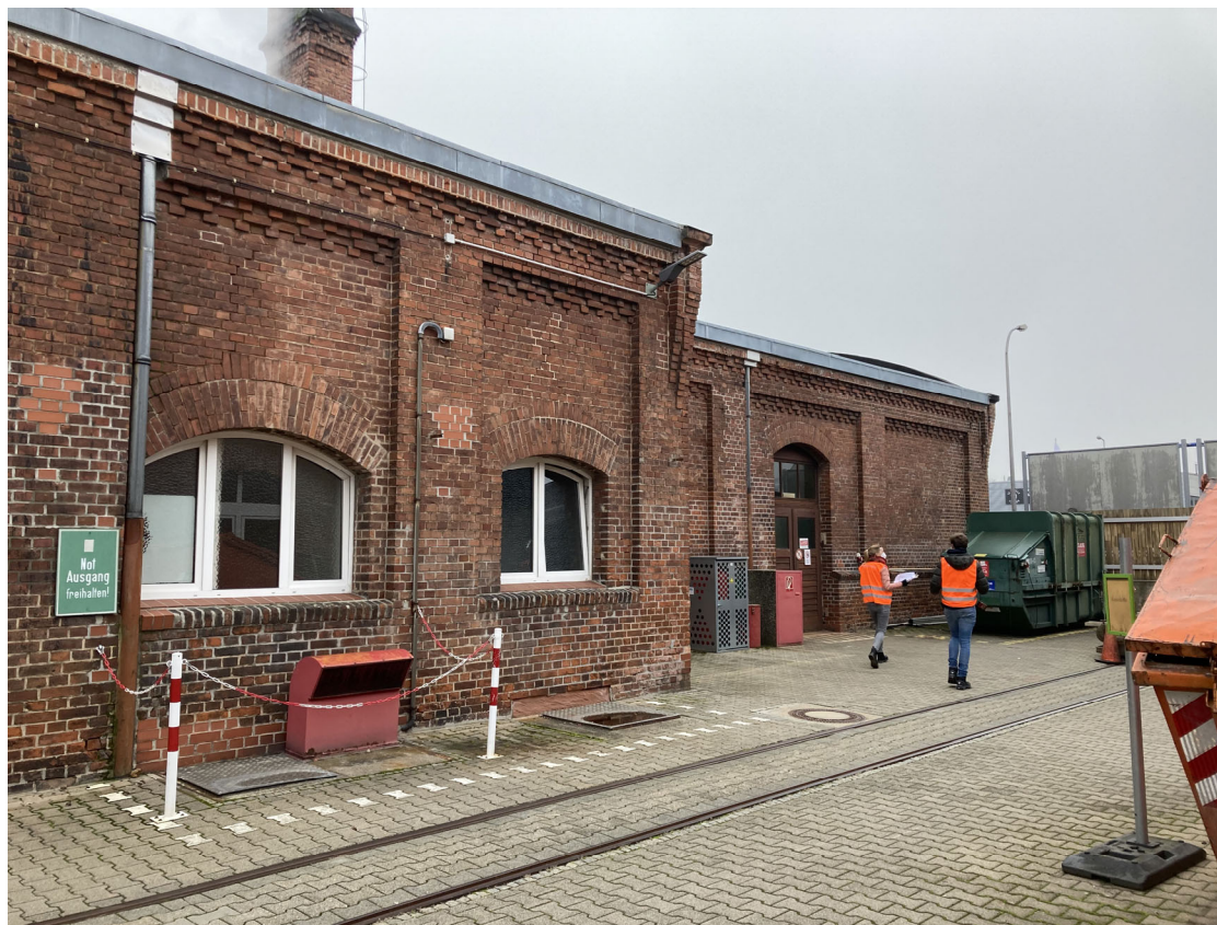
Schachtdeckel - Notausgang und Entlüftungskanal aus Heizkeller im UG, Kunststofffenster
