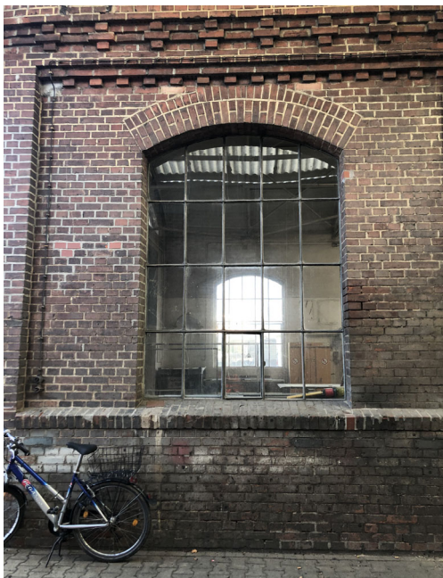
Standard-Fassadenfeld Stahlsprossenfenster, 1-fach Verglasung, gemauerter Sturz, Fensterbank als Rollschicht
