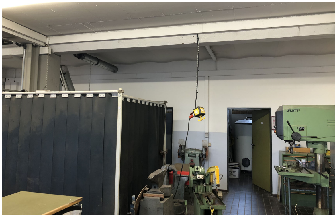
hinterer Bereich Kappendecken, vorne Betondecke mit Stahlträgern und Stahlstützen
