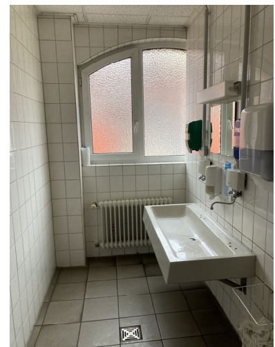
WC-Anlagen, Bodenfliesen, Wandfliesen raumhoch, abgehängte OWA-Decke, Kunststofffenster mit Isolierverglasung
