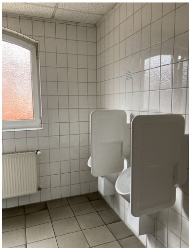
WC-Anlagen, Bodenfliesen, Wandfliesen raumhoch, abgehängte OWA-Decke, Kunststofffenster mit Isolierverglasung
