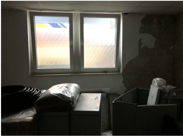
1 - Abstellraum unter Pausenraum, Kunststofffenster, abgehängte OWA-Decke, Zugang nur über angrenzende Bebauung möglich
