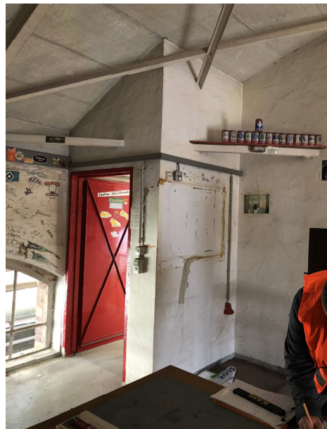
Nachträglich eingezogene Zwischenebene, Nutzung als Pausenraum, Anpassungen der ursprünglichen Segmentbogenfensterelemente
