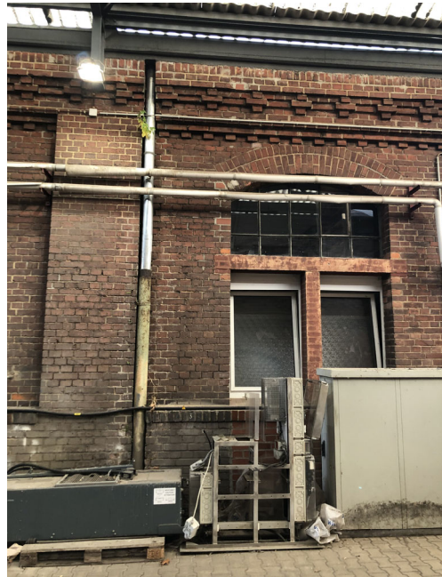
nutzungsbedingte Fassadeneingriffe Einbau einer Zwischenebene, Kunststofffenster
