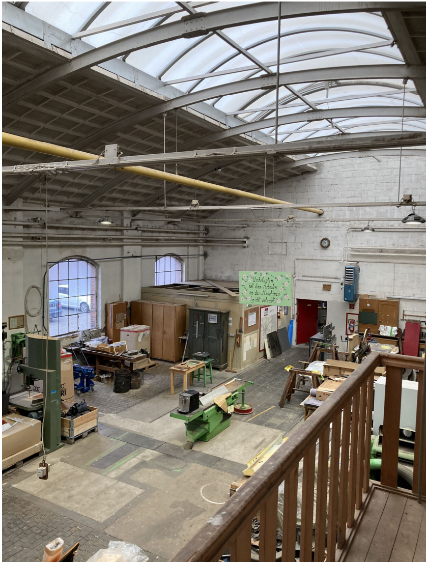
unterschiedliche Fußbodenflächen, Holzpflaster, Betonpflaster, Betonboden
