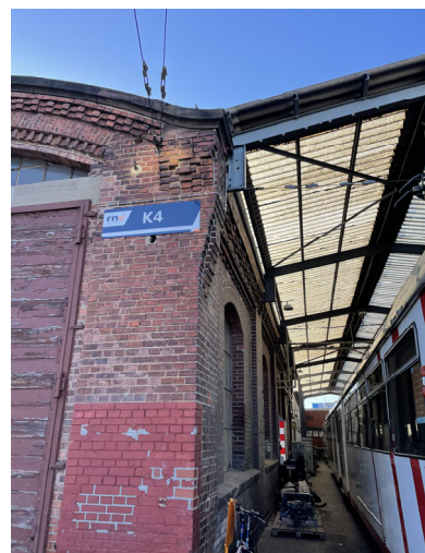
Stahlrahmentore mit Holzbretterfüllung, gemauerter Dachgesimsabschluss mit Sandsteinabdeckung
