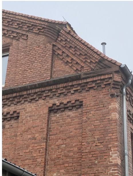
Dachanschluss Ortgangziegel, Mauerwerksfries mit Sandsteinwerkstücken
