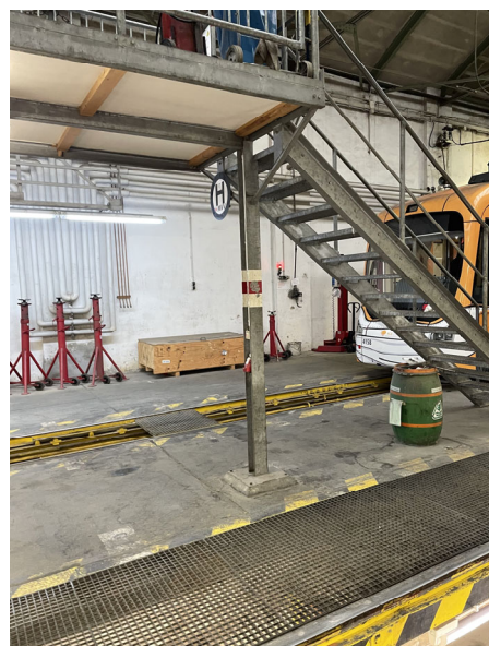
Wartungsbühnen und Wartungsgruben mit seith. Gitterrosteinlagen, Treppenaufgang zu Bühne
