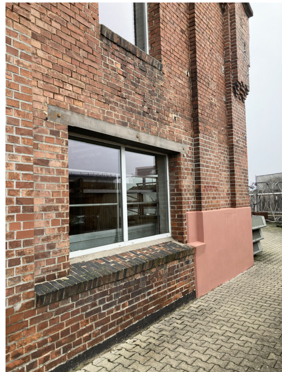
Südansicht - Fassadeneingriffe: Kunststofffenster, Stahlträgerstürze, Rolltor, Reparaturbereich überputzte Fassadenfläche
