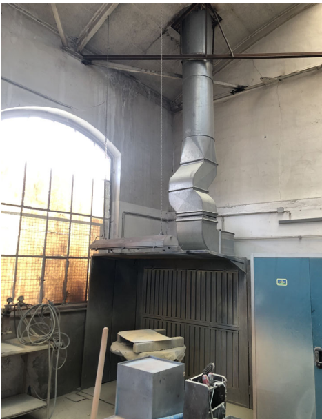
Dachdurchdringung Kaminrohr
