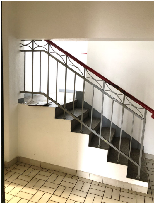
Zugang zu 1. OG, Beton-Werksteinstufen, Metallgeländer mit Holzhandlauf
