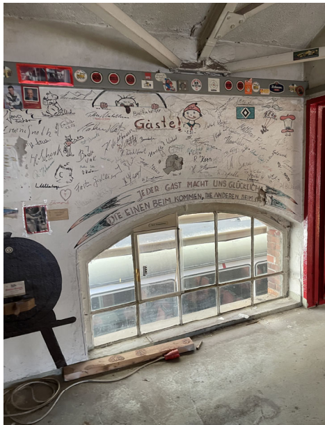
Nachträglich eingezogene Zwischenebene, Nutzung als Pausenraum, Anpassungen der ursprünglichen Segmentbogenfensterelemente
