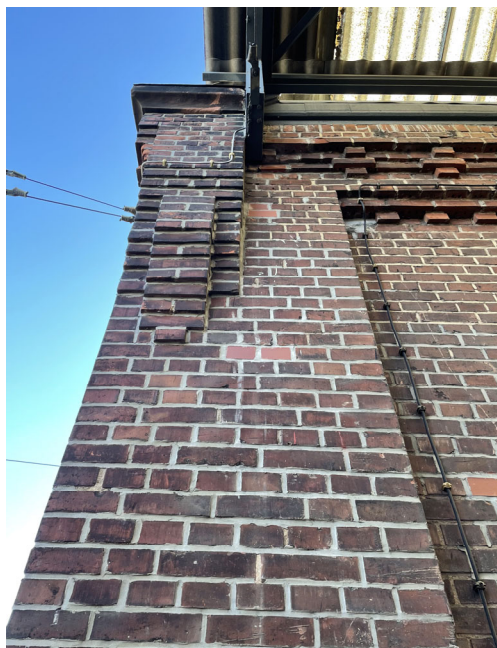
Eckausbildung Gebäude mit separat ausgeformtem Abschlusskopf
