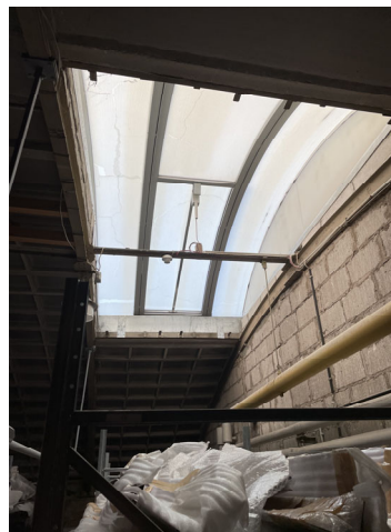
3 OG, Kassettendecke, tlw. provisorisch unterstützt, höhergelegtes horizontales Stahlzugband
