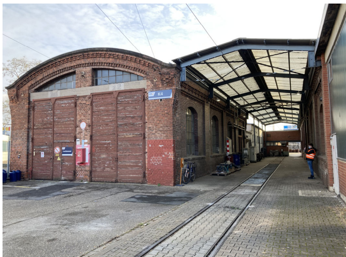
Stahlrahmentore mit Holzbretterfüllung, gemauerter Dachgesimsabschluss mit Sandsteinabdeckung
