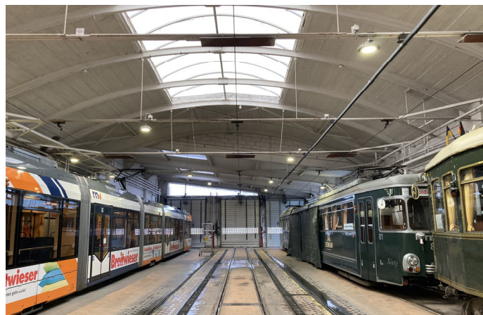
1 Halle 1 - Straßenbahn-Waschanlage, Betonpflaster/Fliesen mit Entwässerungsrinnen
