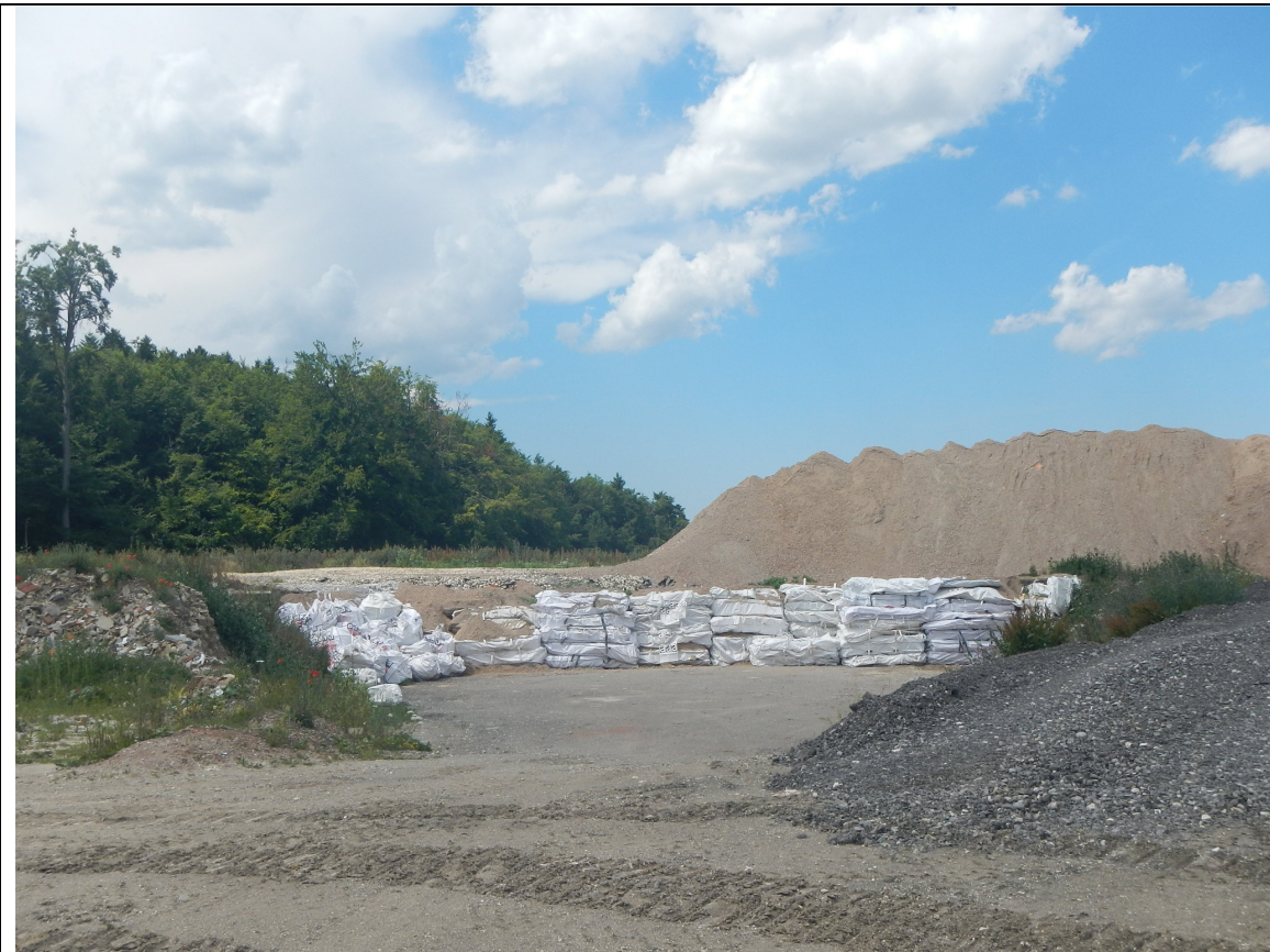
Abb 11: Derzeit in Verfüllung befindliche Deponiefläche, das im Hintergrund liegende Material dient zur Abdeckung der abgelagerten Asbestplattenbags
