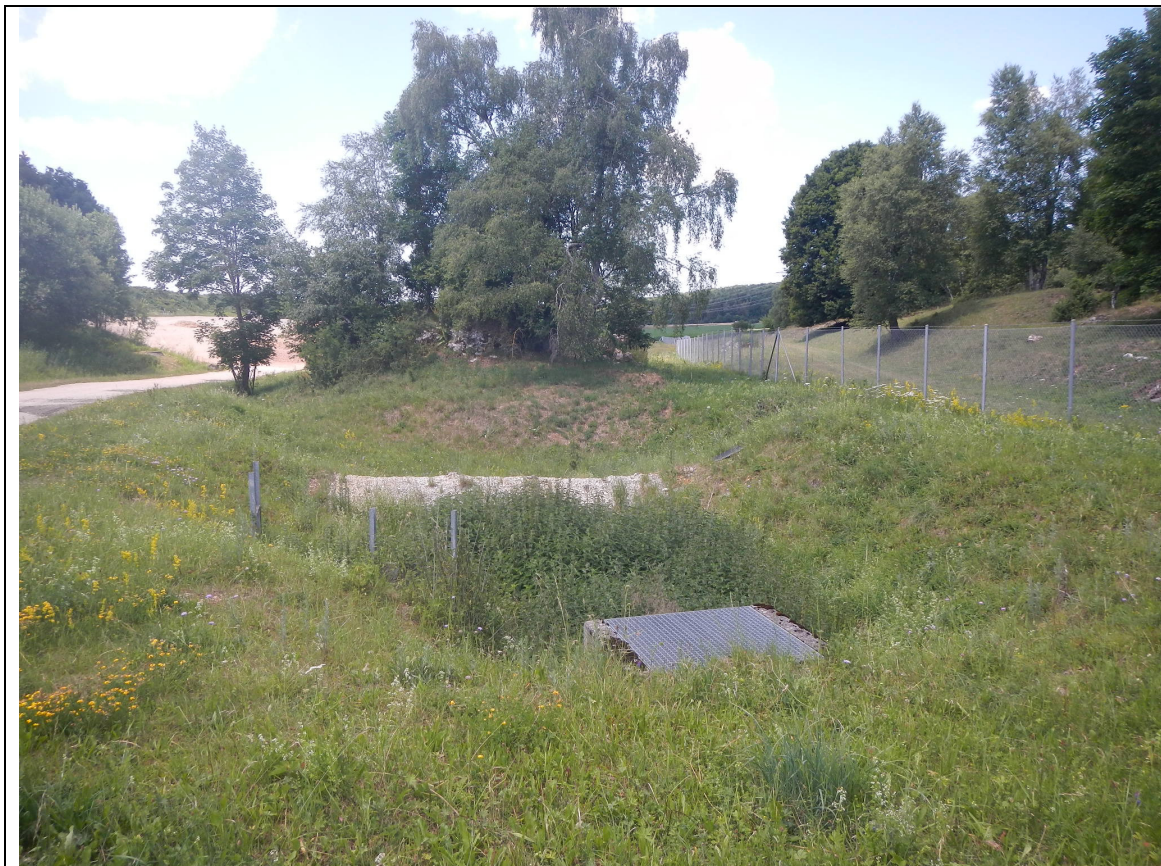
Abb 3: Blick auf das Regensickerbecken, im nahen Hintergrund der bewachsene Felsen, im Hintergrund Recyclingmaterial
