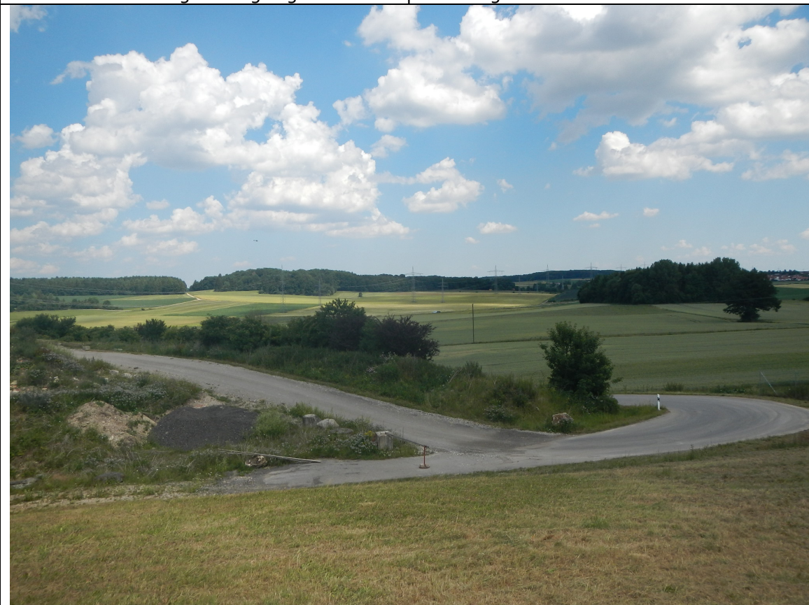
Abb 12: Blick von West nach Ost im südlichen Teil der Deponie
