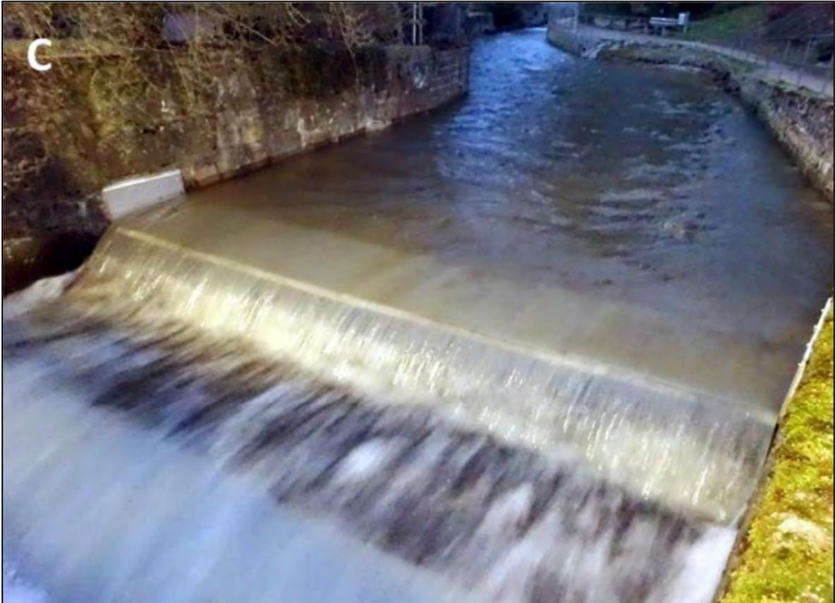
Abbildung 25: Beispiel einer Krebs sperre vergleichbarer Ausführung (Quelle: HLNUG 2017 © C. Chucholl)
