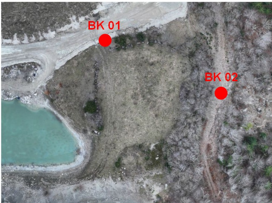
Abb. 17: Bohransatzpunkte der beiden Kernbohrungen BK 01 und BK 02 von 2013 rechts neben dem äußeren Wasserbecken (Bild: Fa. Holcim).
