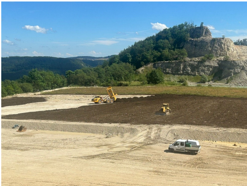
Abb. 10: Beispiel von Arbeiten zur Herstellung der Rekultivierungsflächen im Juli 2024. Zu sehen ist die im Mittel ca. 1,7 m mächtige Speicherschicht aus gebrochenem Kalkstein so wie die Arbeiten zur Herstellung der Oberbodenschicht (Bild: freundliche Bereitstellung durch die Fa. Peter Unternehmungen).
