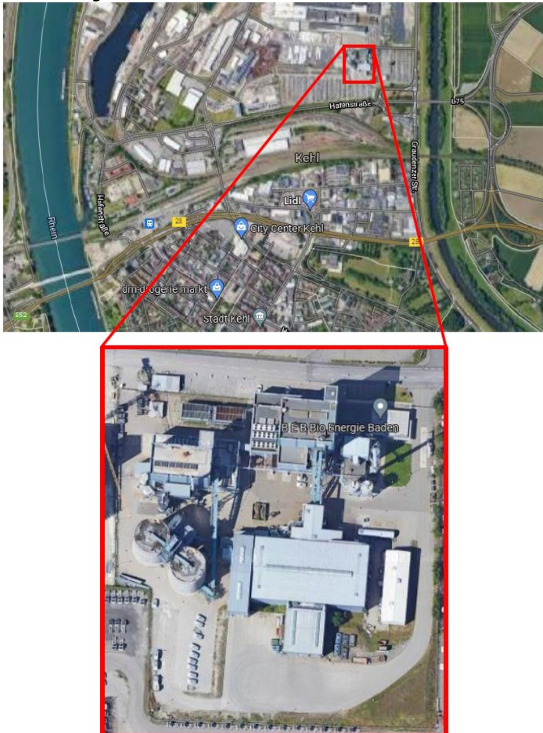
Abb. 2: Lage des Biomasse-Kraftwerks im Luftbild
