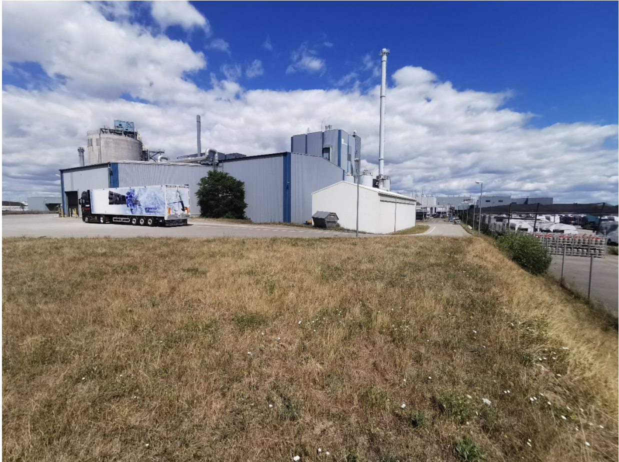
Abb. 34: Foto des bestehenden Kraftwerks und den Ruderalfluren am Standort der geplanten der Anlage
