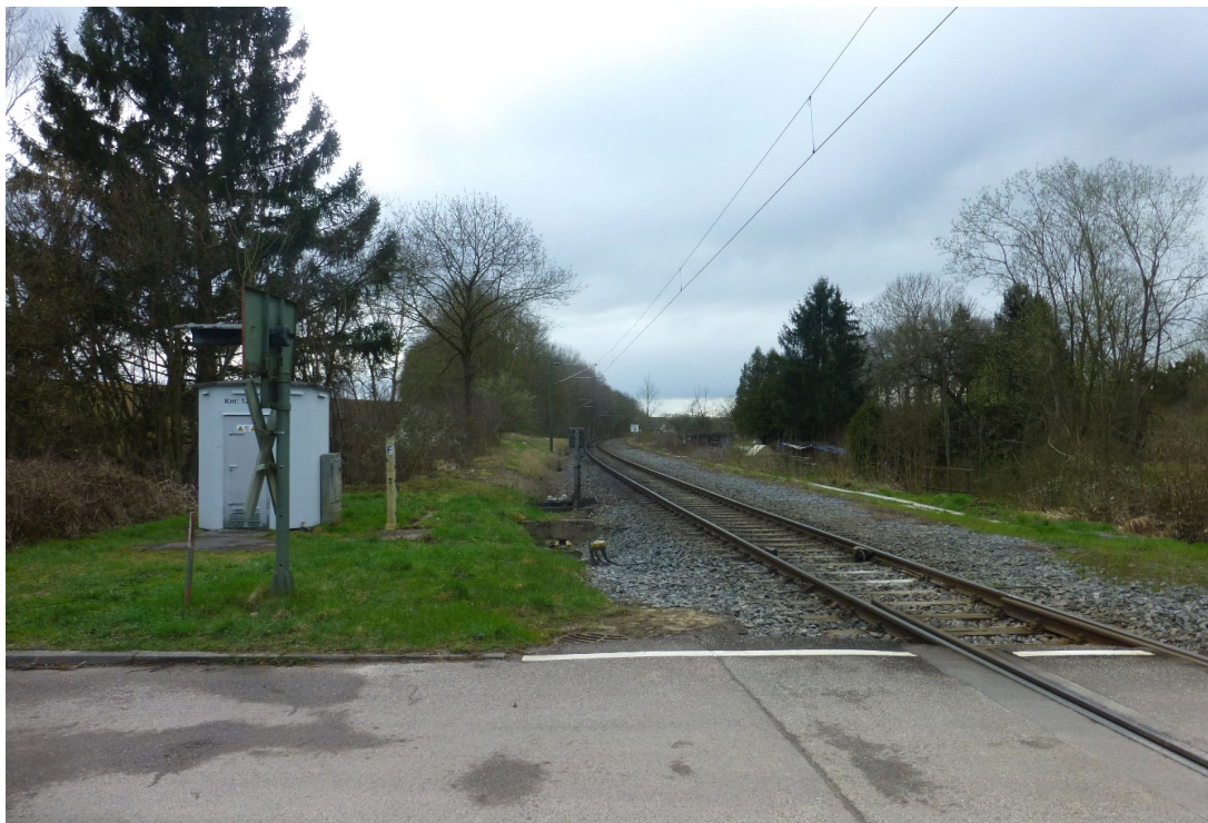
Abb. 5: Bahnübergang bei Bahn-km 127,3, Blickrichtung West.
