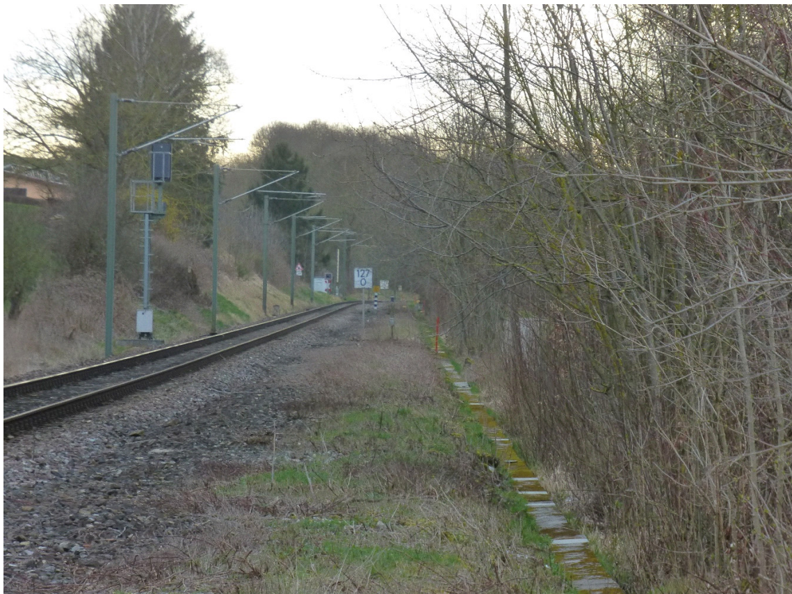
Abb. 4: vorhandener Erdkörper der ehemaligen Zweigleisigkeit.
