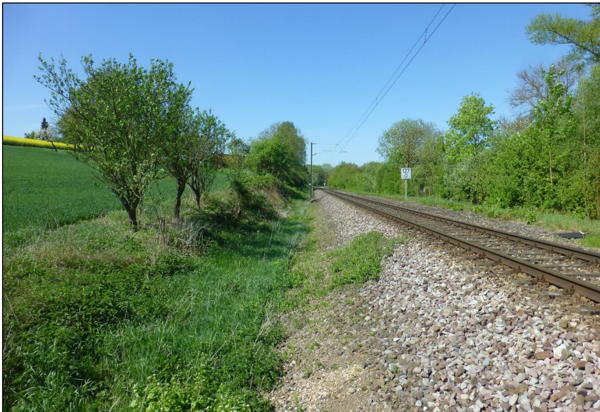
Abb. 2: Blick entlang der aktuell im Betrieb befindlichen Strecke bei km 127,0
