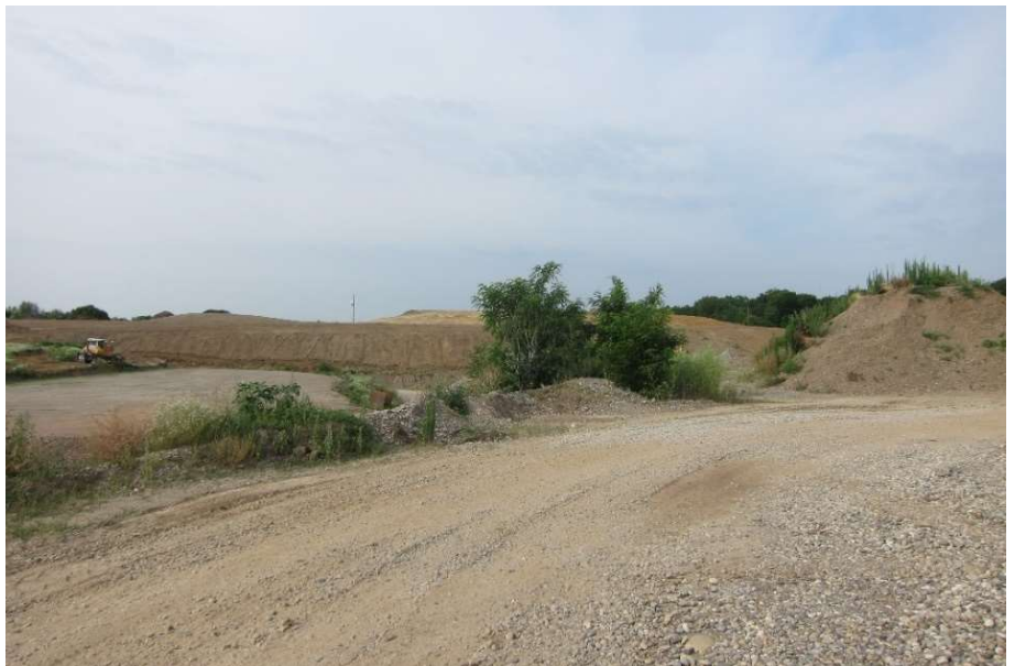
Abbildung 4-4: Kiesige Aufschüttungen (Hintergrund) und befahrene Flächen (Vordergrund)
