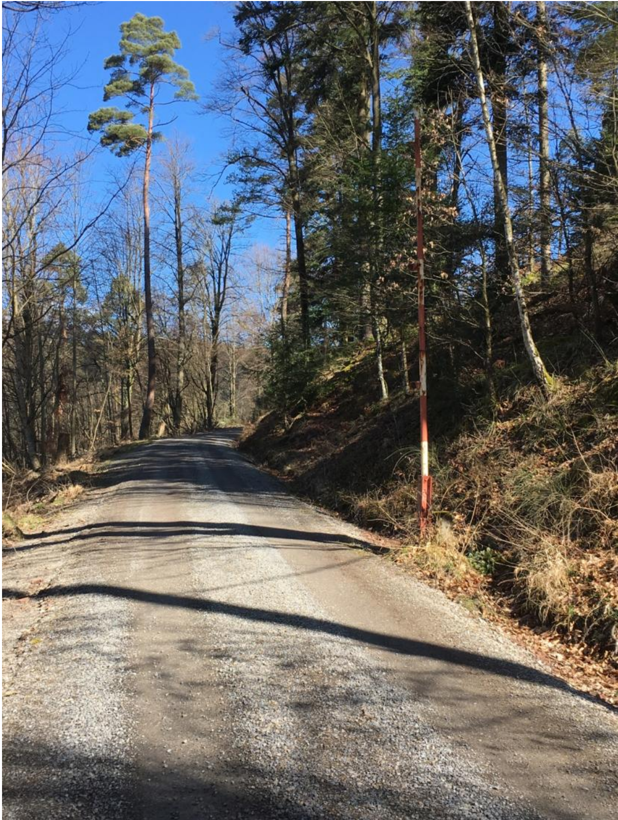
Abbildung 13: Bild 3 Ausbaurzustand der Forstwege, Bereich Zufahrt Windpark.
