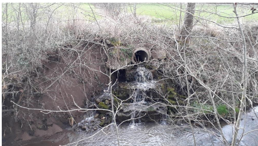
Glemsbach mit stark verbautem Einmündungsbereich in die Würm (April 2018)
