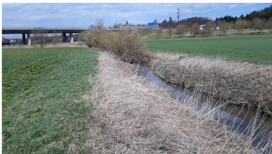
Würm mit vergleichmäßigten Uferböschungen oberhalb der Brücke der Autobahn 81 (April 2018)
