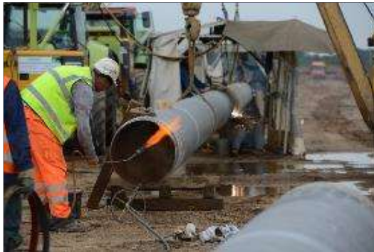
Abbildung 11: Vorbereitung der Rohrenden für Schweißarbeiten (Quelle: terrannets bw)
