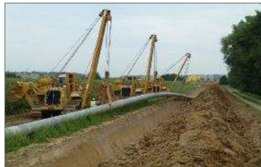
Abbildung 17: Rohrverlegearbeiten mittels mehrerer Rohrleger (Quelle: terrane ts bw)
