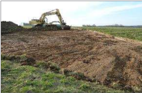
Abbildung 5: Abheben des Oberbodens (Quelle: terrane ts bw)
