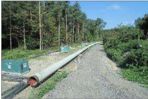
Abbildung 13: Vorgestreckter Rohrstrang nach Schweißarbeiten und Prüfung (Quelle: terrane ts bw)
