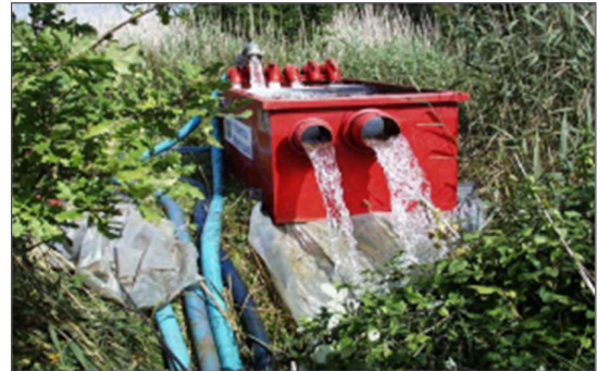
Abbildung 14: Filteranlage zum Schutz der Vorflut im Falle einer Wasserhaltung (Quelle: terrane ts bw)
