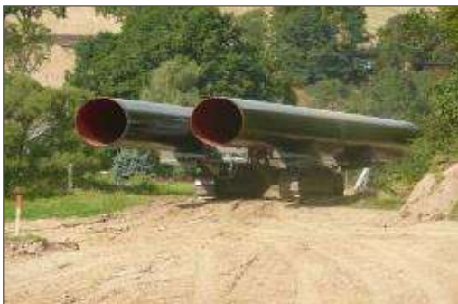
Abbildung 7: Rohrausfuhr mittels speziellem Transportgerät (Quelle: terrane ts bw)
