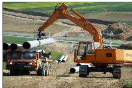
Abbildung 8: Vorlegen der geraden Rohre entlang der Leitungstrasse (Quelle: terrane ts bw)
