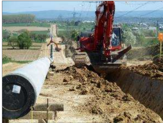
Abbildung 15: Herstellung des Rohrgrabens im Anschluss an die Vorstreckarbeiten mit einem speziell geformten Baggerlöffel (Quelle: terrane ts bw)
