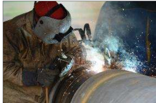
Abbildung 12: Manuelle Schweißarbeiten durch speziell ausgebildetes und zertifiziertes Fachpersonal (Quelle: terrannets bw)
