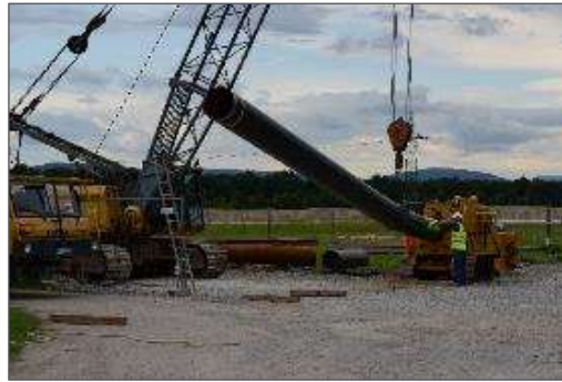
Abbildung 9: Biegemaschine im Betrieb (Quelle: terrane ts bw)
