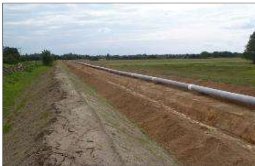
Abbildung 16: Vorbereitetes Baufeld für die Verlegung der Rohrleitung (Quelle: terrane ts bw)
