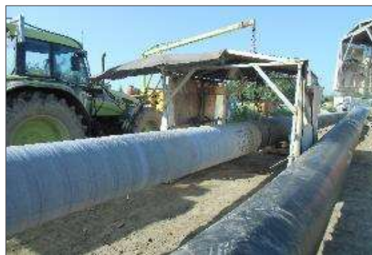
Abbildung 10: Schweißeinrichtung außerhalb des Rohgrabens zum Vorstrecken gerader Leitungsabschnitte (Quelle: terrane ts bw)
