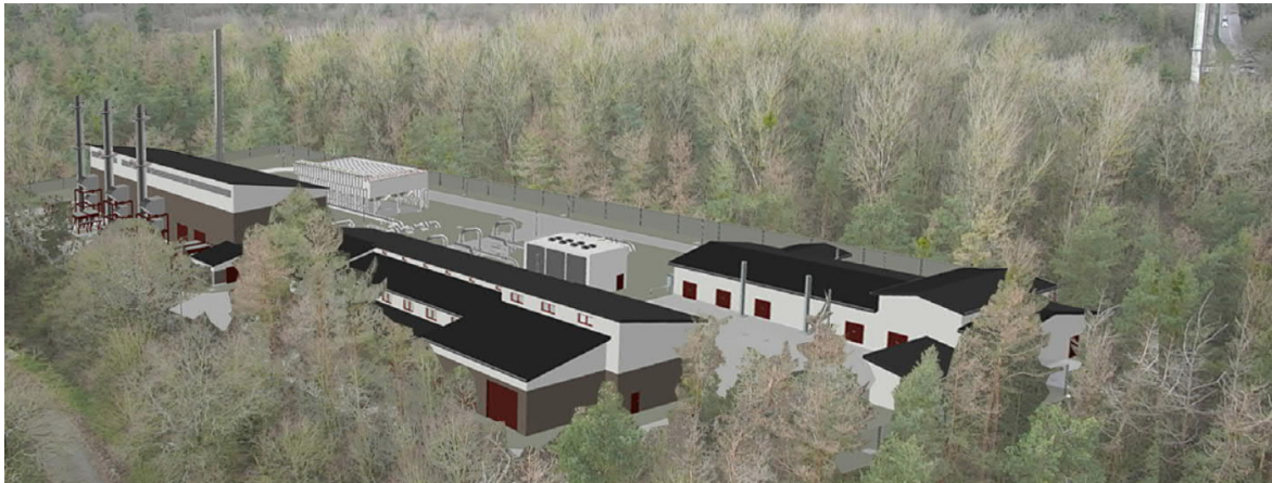
Abb. 14: Beispielhafte Darstellung der Verdichterstation
