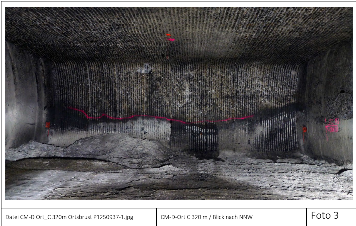
Ortsbrust: Aufschluss in den Unteren Sulfatschichten (Top = magentafarbene Linie). Dunkle Lage (Bildmitte) = obere Teile des Dolomit-Anhydritsteins (Kammerhöhe 5,1 m).
