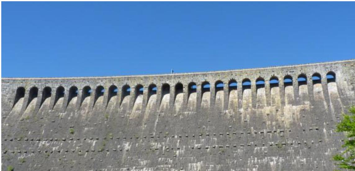
Abbildung 25: Ansicht der Staumauer der Schwarzenbachtalsperre mit Überlaufdurchlässen.
