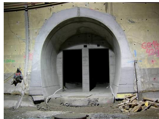
Abbildung 17: Beispiel schonender Durchbruch aus einem bestehenden Tunnel in den Berg
