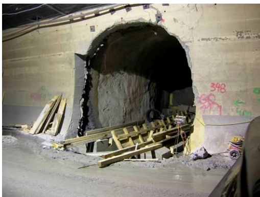
Abbildung 17: Beispiel schonender Durchbruch aus einem bestehenden Tunnel in den Berg
