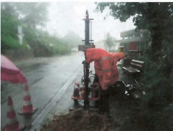
Foto 23: Rammsondierung bei BK 3 / DPH 3
