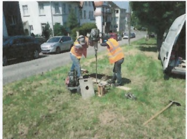
Foto 16: Rammkernsondierung bei RKS 8 / DPH 5
