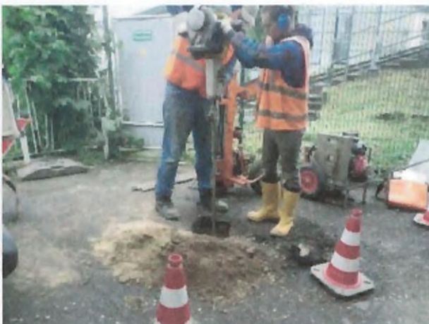
Foto 17: Rammkernsondierung bei RKS 9 / DPH 4
