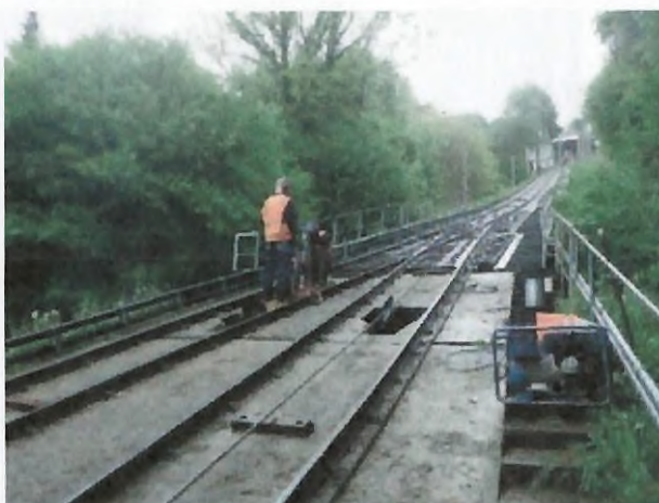
Foto 5: Kernbohrung bei KB 5 / RKS 3
