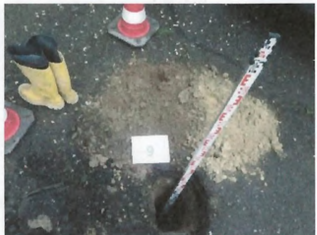
Foto 18: Vorschacht und Aushub bei RKS 9 / DPH 4
