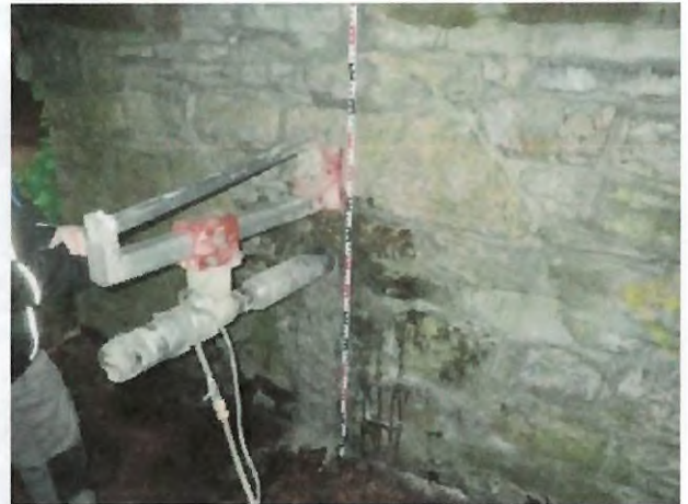
Foto 29: Kernbohrung bei KB 1
