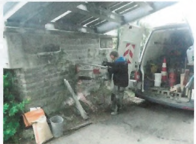
Foto 32: Kernbohrung bei KB 2
