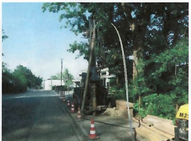
Foto 24: Maschinenkernbohrung bei BK 3 / DPH 3
