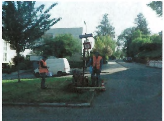
Foto 20: Rammsondierung bei BK 2 / DPH 2
