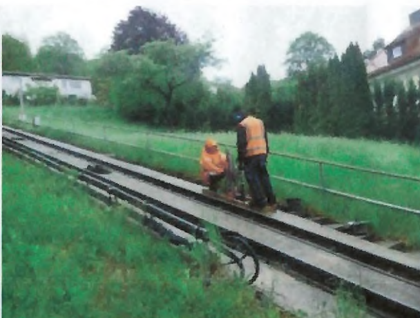
Foto 11: Kernbohrung bei KB 8
