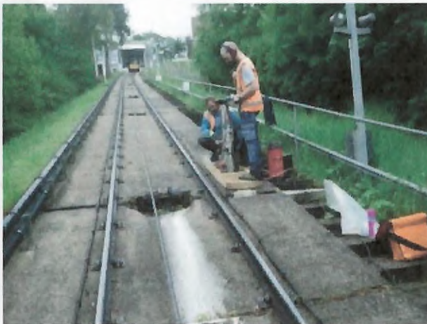
Foto 3: Kernbohrung bei KB 4 / RKS 2
