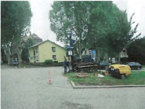
Foto 21: Maschinenkernbohrung bei BK 2 / DPH 2
