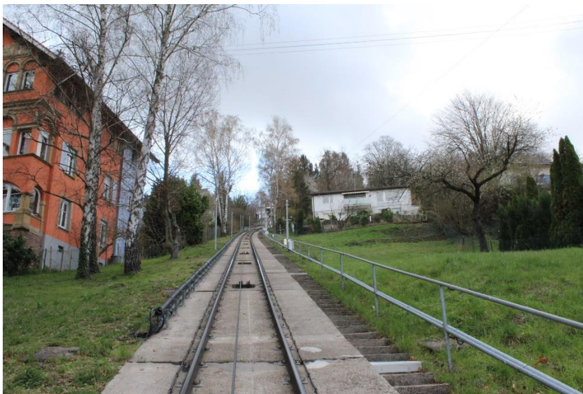
Foto 2 Unterer Teil Bestands- strecke
