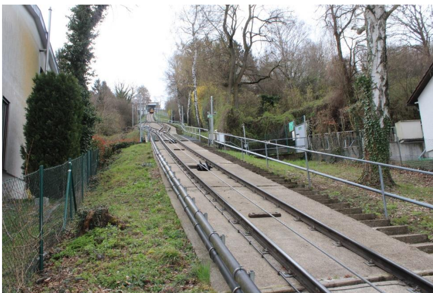
Foto 3 Mittlerer Teil Bestands- strecke
