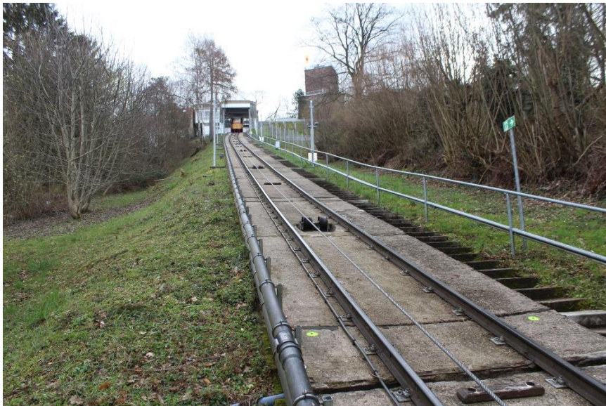
Foto 4 Oberer Teil Bestands- strecke
