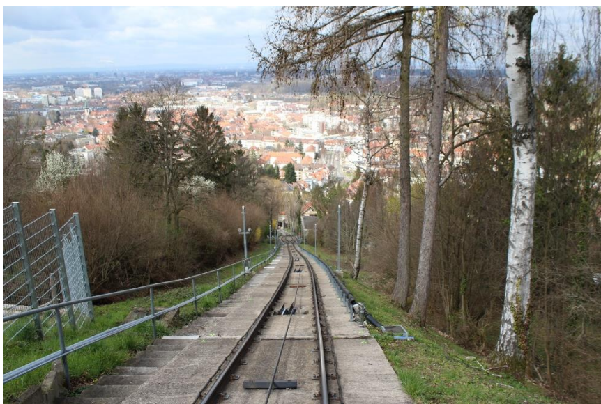
Foto 5 Talblick von der Berg- station
