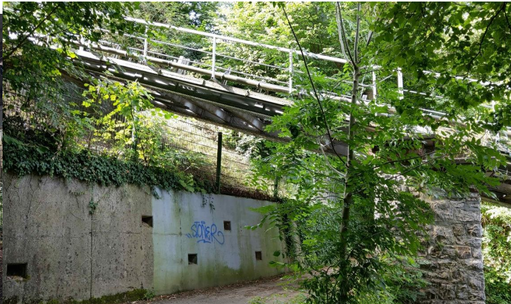
best. Stützmauer bergseits (links auf dem Bild) best. Widerlager Mitte (rechts auf dem Bild)
