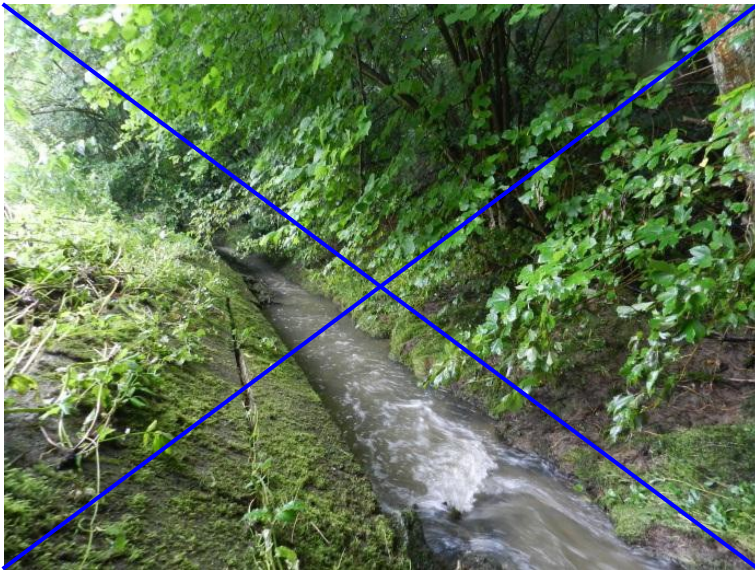
Regelprofil des ausgebauten Ramsbachs Foto: Geitz & Partner 2013
