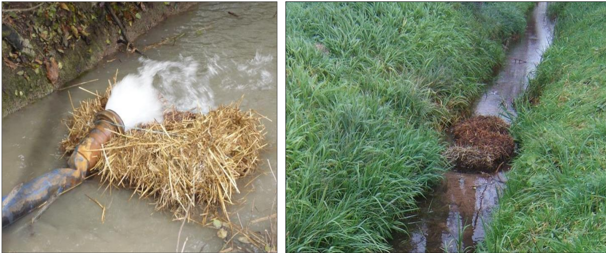
Abbildung 2: Maßnahme Substratfang: Strohballenfilter (Beispiel)
