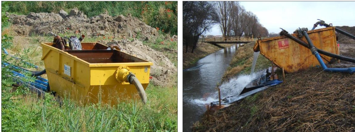
Abbildung 1: Maßnahme Klär und Absetzcontainer (Beispiel)
