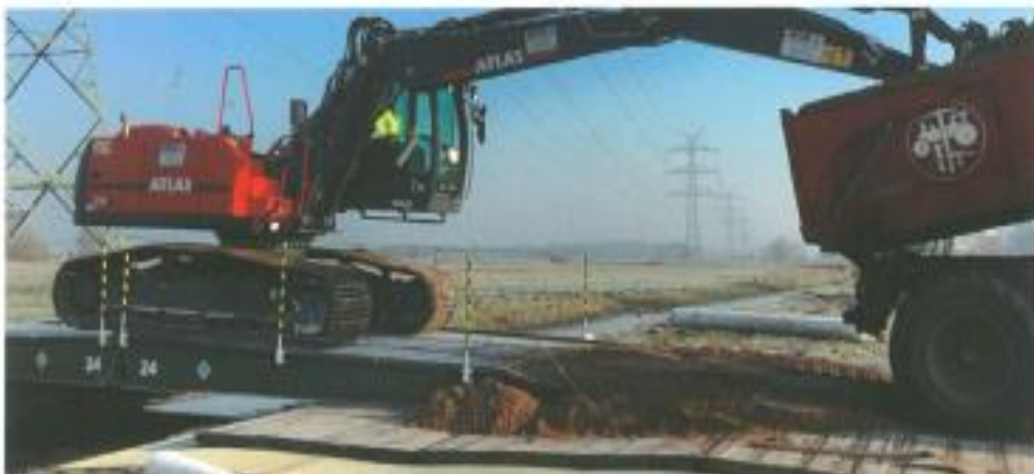
Abbildung 2 Gewässerquerung Mobile Brücke
