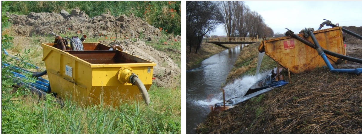
Abbildung 1: Maßnahme Klär und Absetzcontainer (Beispiel)
