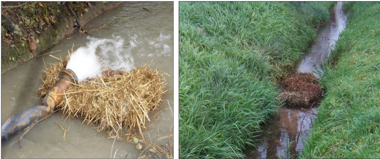
Abbildung 2: Maßnahme Substratfang: Strohballenfilter (Beispiel)
