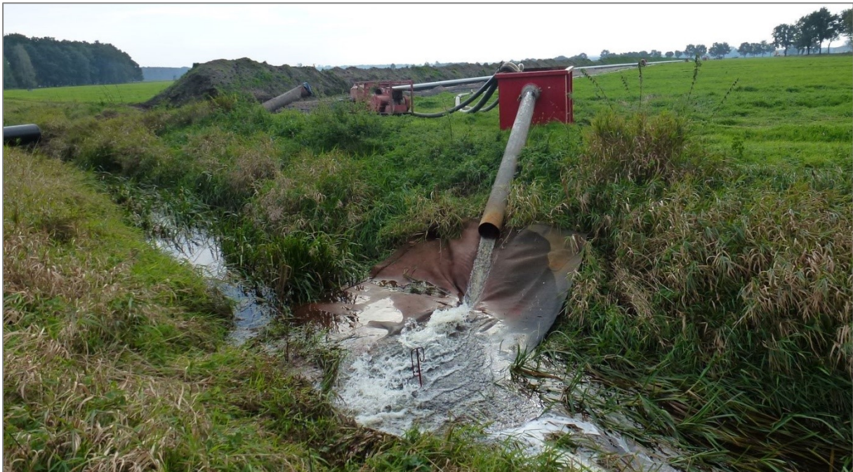
Abbildung 2: Bsp.: Einleitung des Grundwassers in Oberflächengewässer mit Schutz vor hydraulischer Belastung
