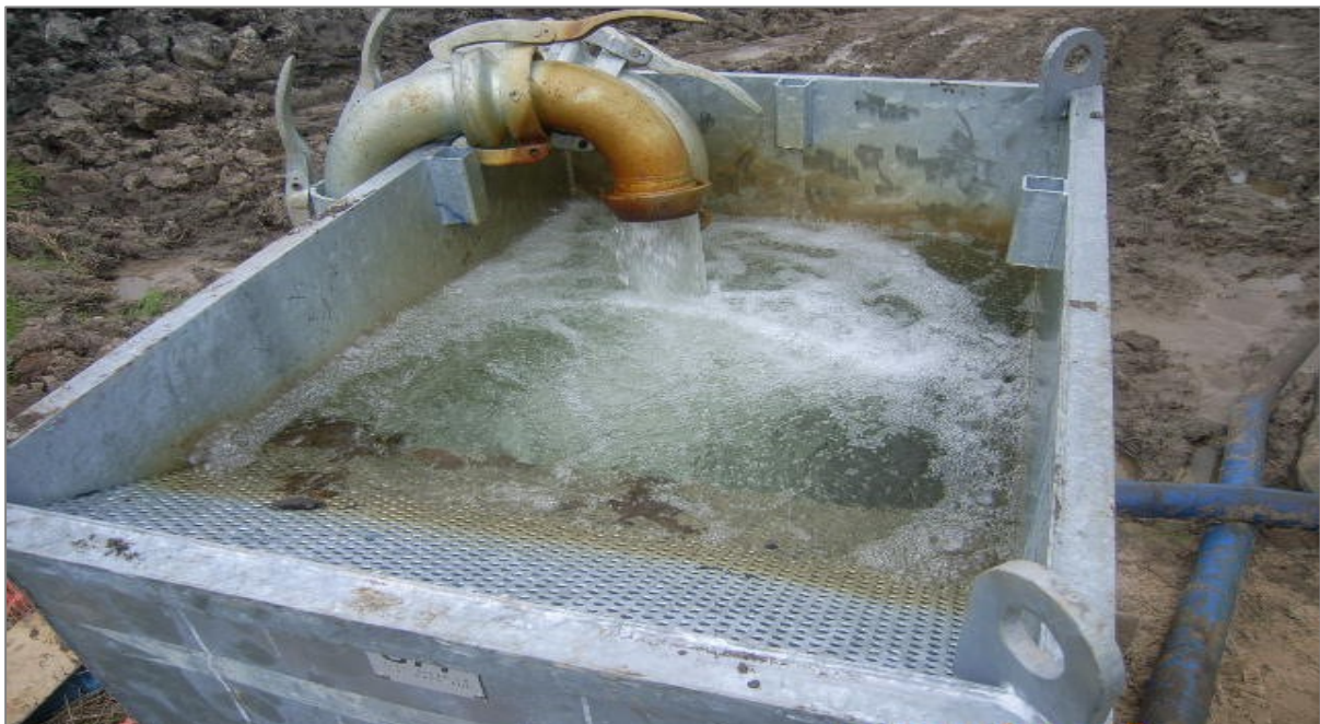
Abbildung 3: Bsp.: Klär- und Absetzbecken
