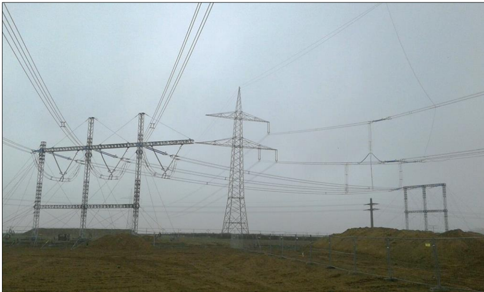
Abbildung 26: Provisorium mit Abankerung
