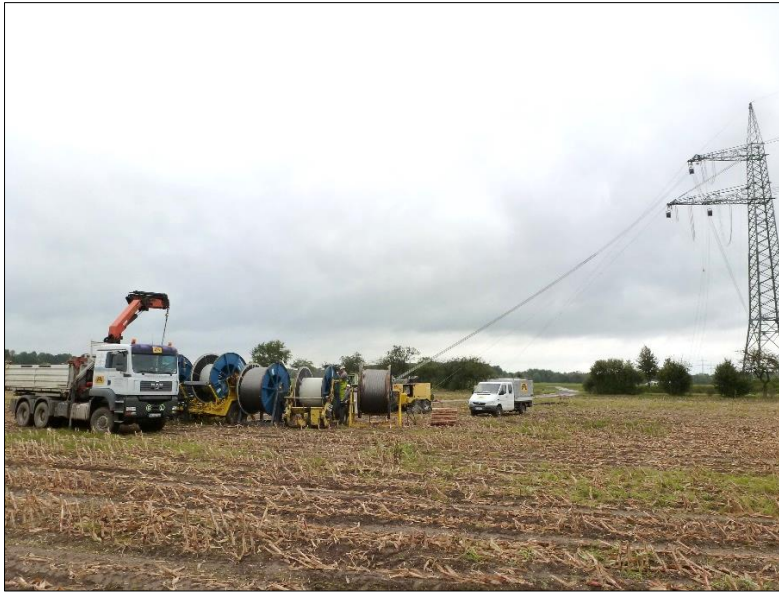
Abbildung 24: Seilzugarbeiten
