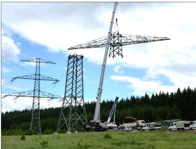
Abbildung 22: Maststocken mit Mobilkran
