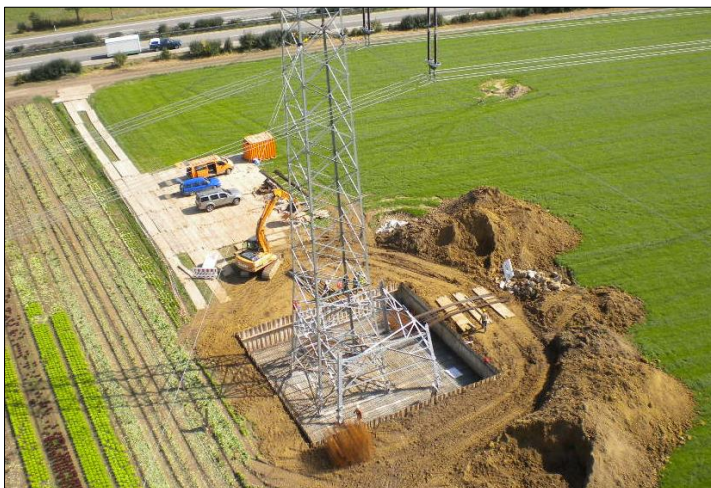
Abbildung 21: Baustelleneinrichtung mit Fundamentgrube
