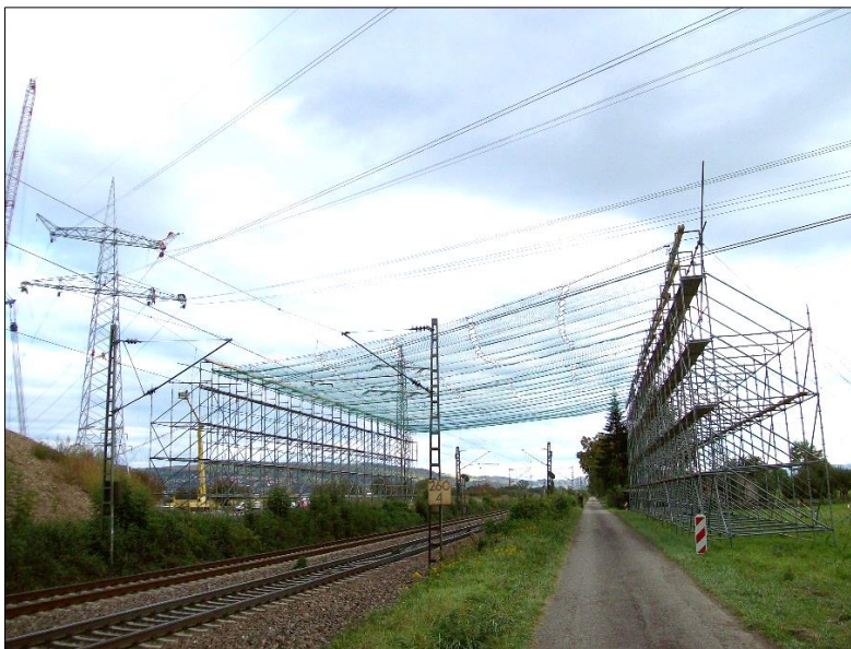
Abbildung 23: Schutzgerüst an einer Bahntrasse
