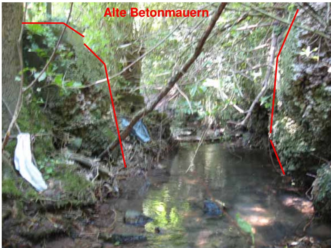
Abbildung 1: Alte Betonufereinfassungen des Beutenbachs bei Grundstück 2229/5
