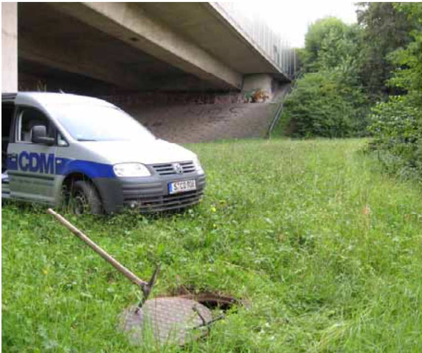
Abbildung 22: Schacht mit Rohr-T-Stück
