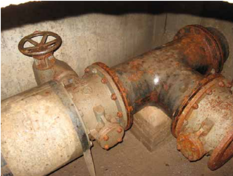
Abbildung 23: Rohrleitungs-T-Stück mit Schieber
