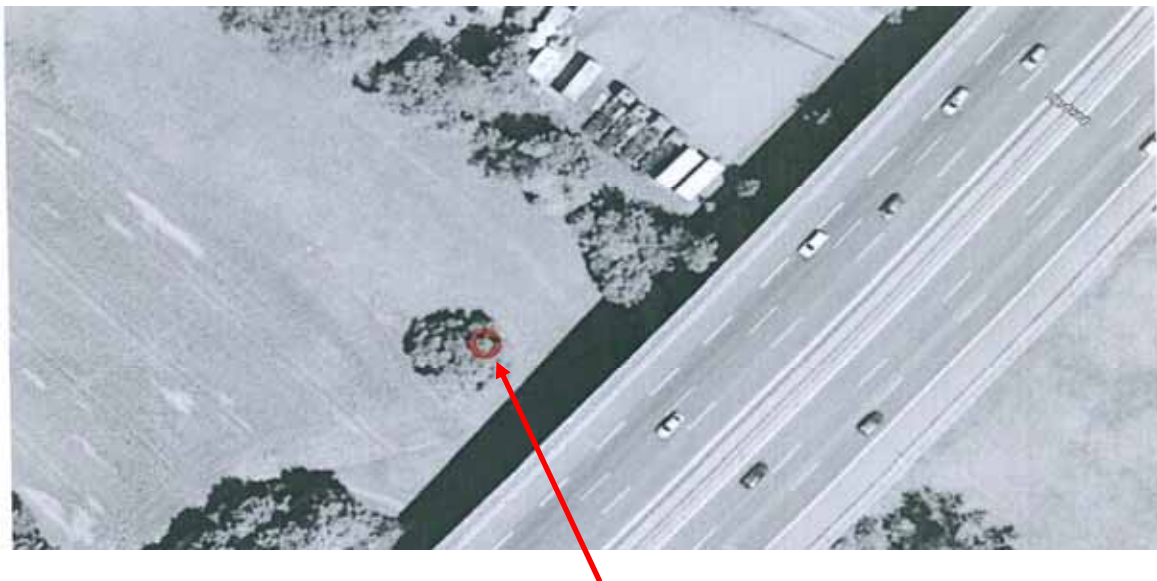
Abbildung 6: Vermutete Lage des ehemaligen Beutenbachbrunnens an der Autobahn
