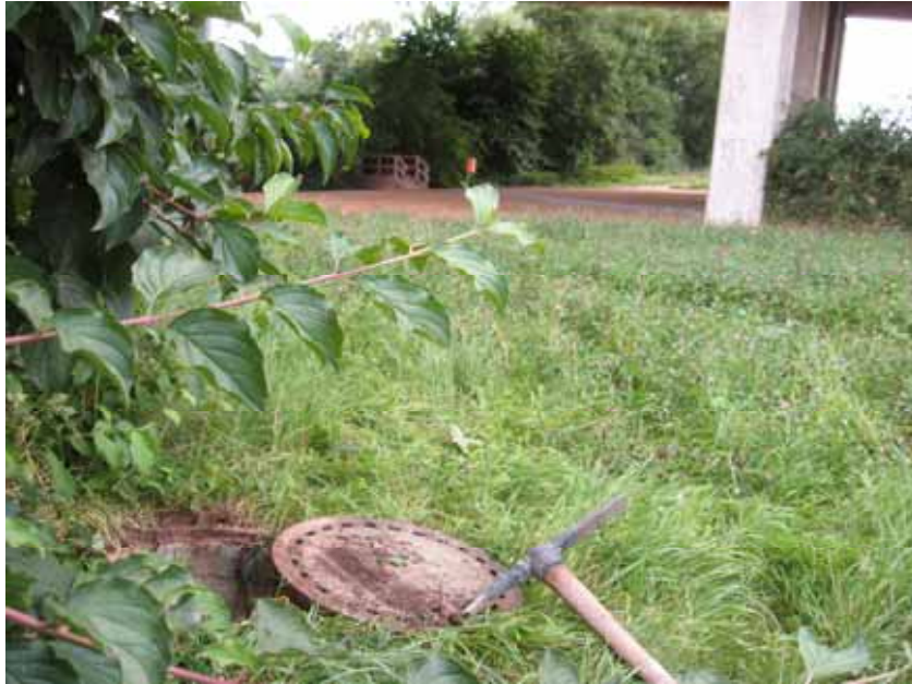
Abbildung 19: Entwässerungsschacht an der Autobahn
