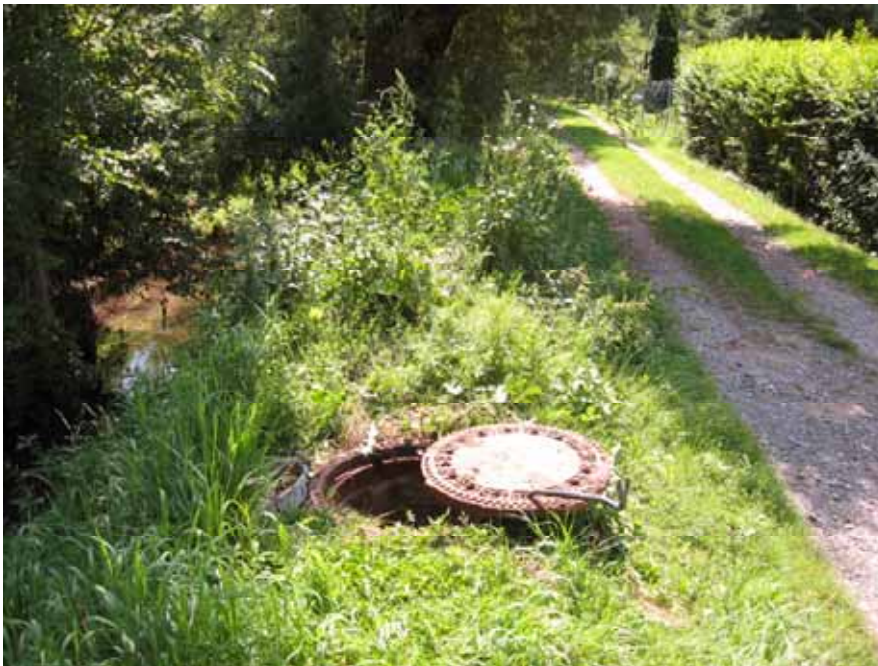
Abbildung 17: Zweiter Schacht der Abwasserkanalisation im Oberen Scheffzental
