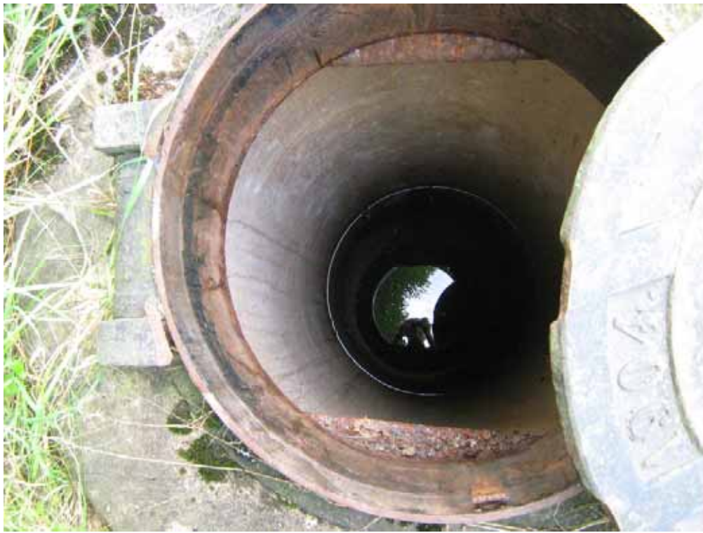
Abbildung 13: Erlenbrunnen mit abgebrochenem Deckel
