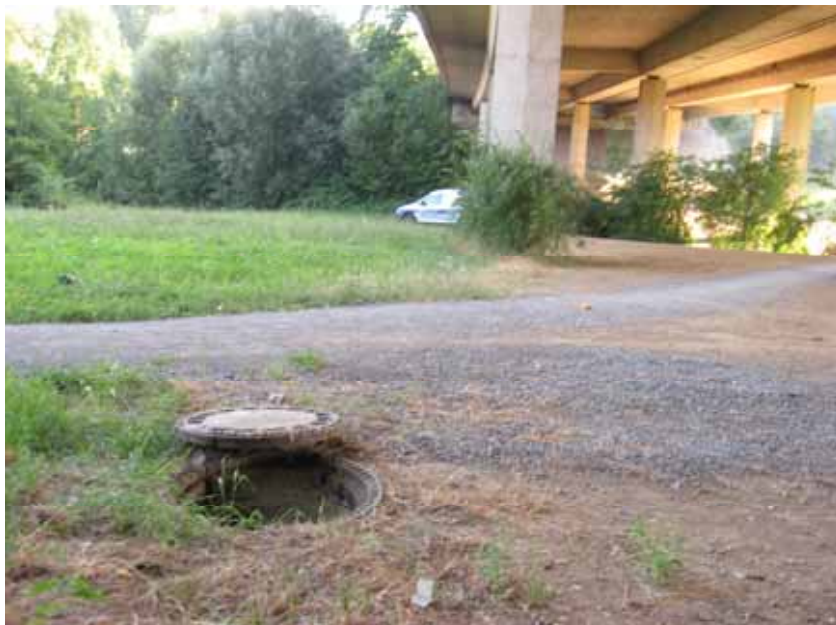
Abbildung 20: Weiterer Entwässerungsschacht an der Autobahnbrücke
