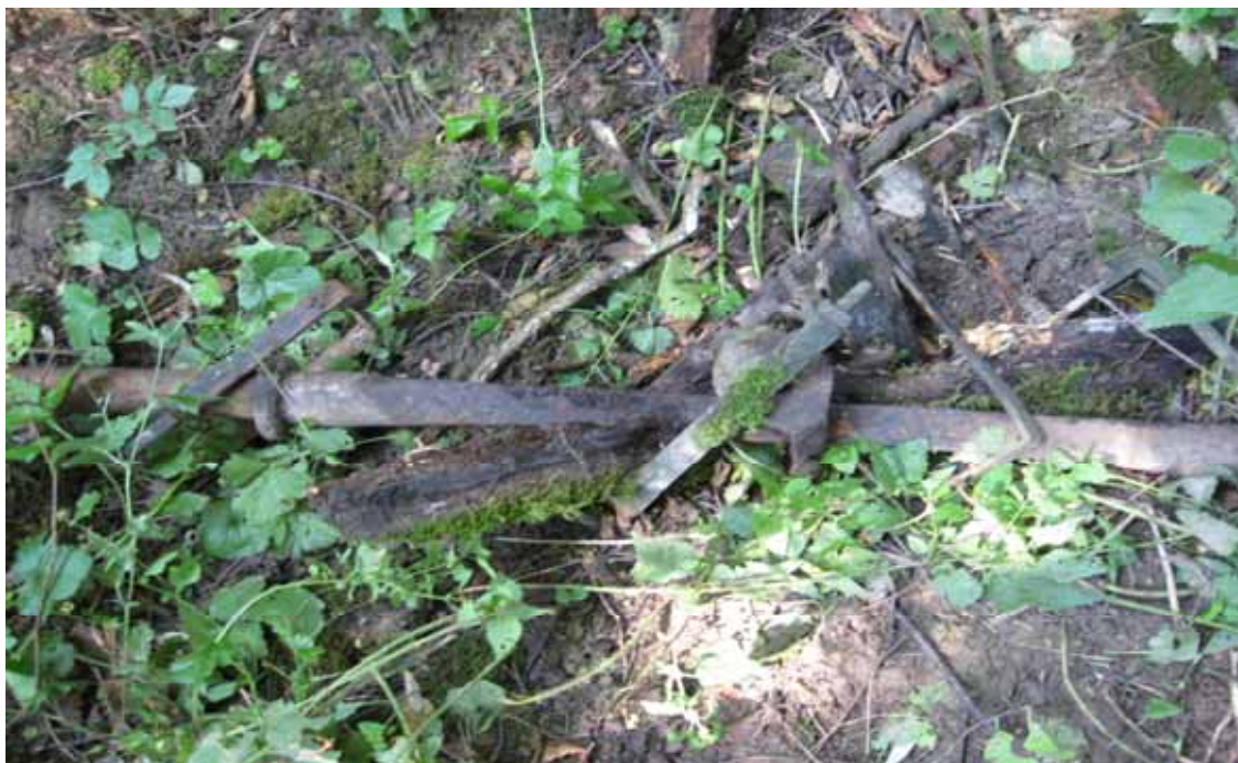
Abbildung 2: Altes Schachtrohr und Steigeisen
