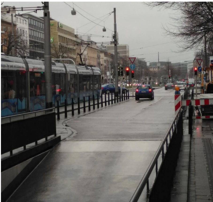
Abbildung 4: Bestandssituation Ausfahrt Tiefgarage Hauptbahnhof
