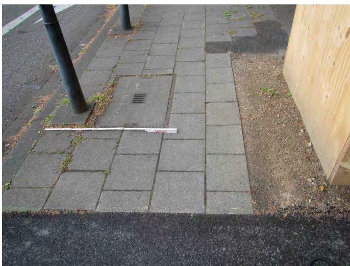
Baumstandort im Kronenbereich und Umfeld, offene Baumscheibe umgeben von versiegelten Flächen und Einrichtungen der Infrastruktur (Kabelkanal)
