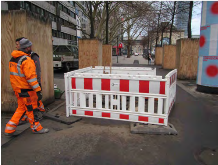
Schürf im Bereich einer bestehenden Linde (Baum 31)
