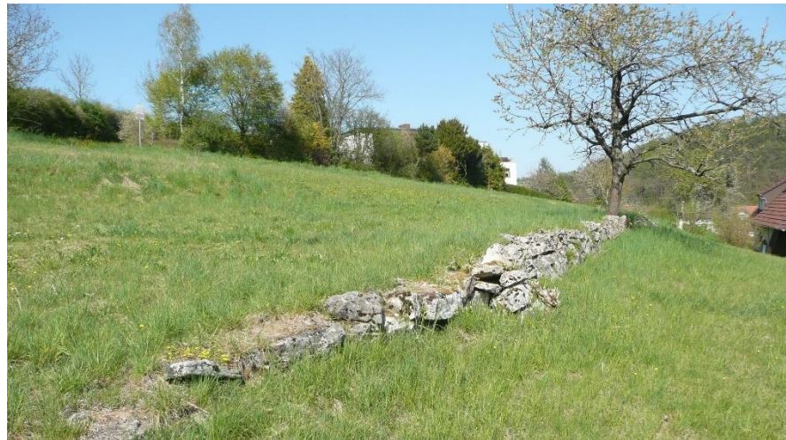
Niedrige Trockenmauer auf südexponierter Böschung
