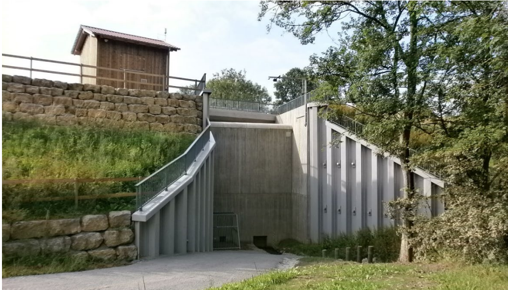
Abbildung 4: Beispiel für ein HRB mit Flügelwänden in Spundwandbauweise (HRB Glasofenbach, WV Wieslauftal)
