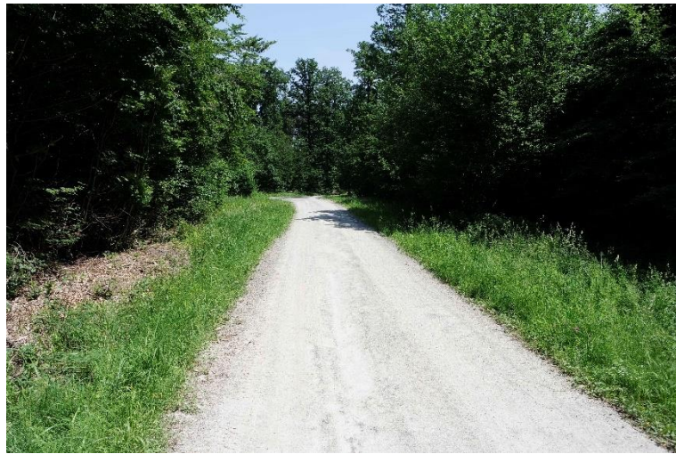
Abbildung 10: Zuwegung im Bereich des vorhandenen, geschotterten Hauptforstwegs (Foto © DNP, Juni 2021)
