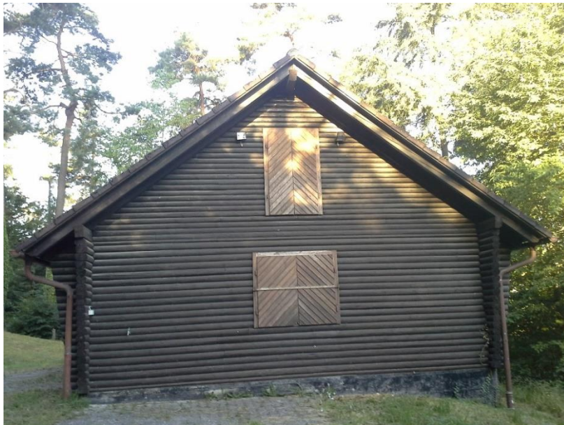
Abbildung 14: Forsthaus „Klankhütte“ als Balz- und Wochenstubenquartier von Zwergfledermäusen (Foto © DNP)
