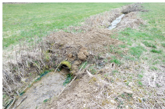
Foto 6: Abschnitt 04 des Horrenbachs mit Durchlass
