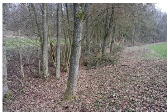
Foto 12: Abschnitt 03 des Hollergrabens - Gewässerlauf als Mulde erkennbar
