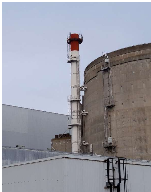
Figure 2.w Vue de la cheminée du BAN © EDF
