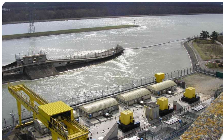
Figure 2.q Vues aériennes de l'ouvrage de prise d'eau et de la station de pompage © EDF
