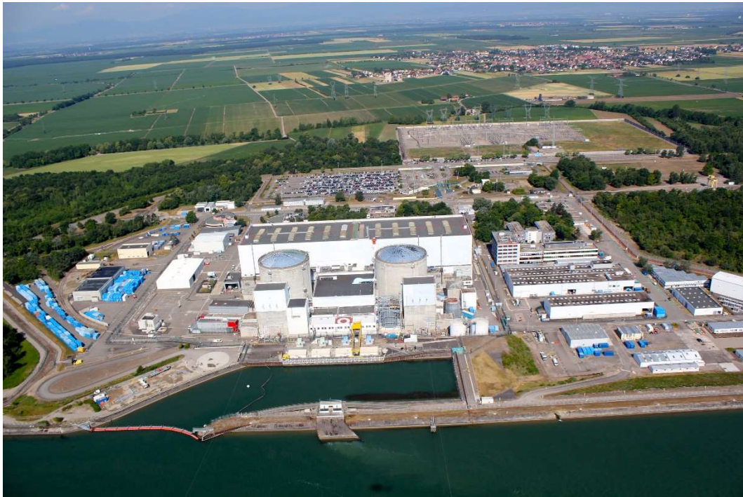
Figure 12.b Vue du site © EDF
