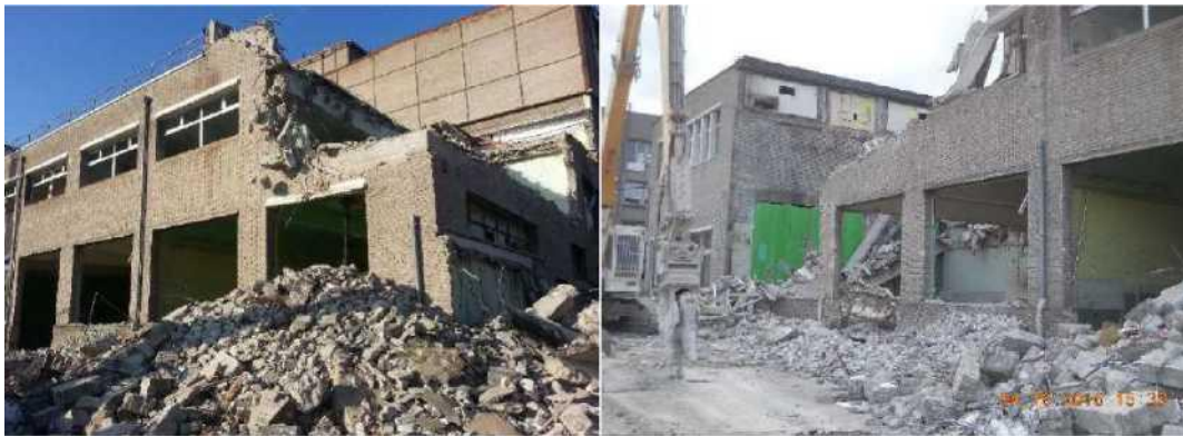
Abbildung 9.k Abbildung einer Abrissphase – Dekonstruktion von Verwaltungsgebäuden und Werkstätten des Wärmekraftwerks Richemont
