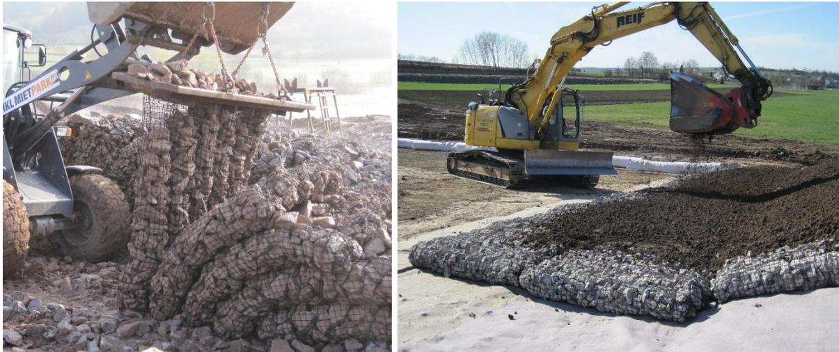
**Abbildung 29: Einbau Geogittermatratzen an HWEA**
