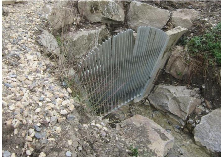
**Abbildung 18: Einlauf Brühlbachverdolung am Bahndamm im Bestand**
