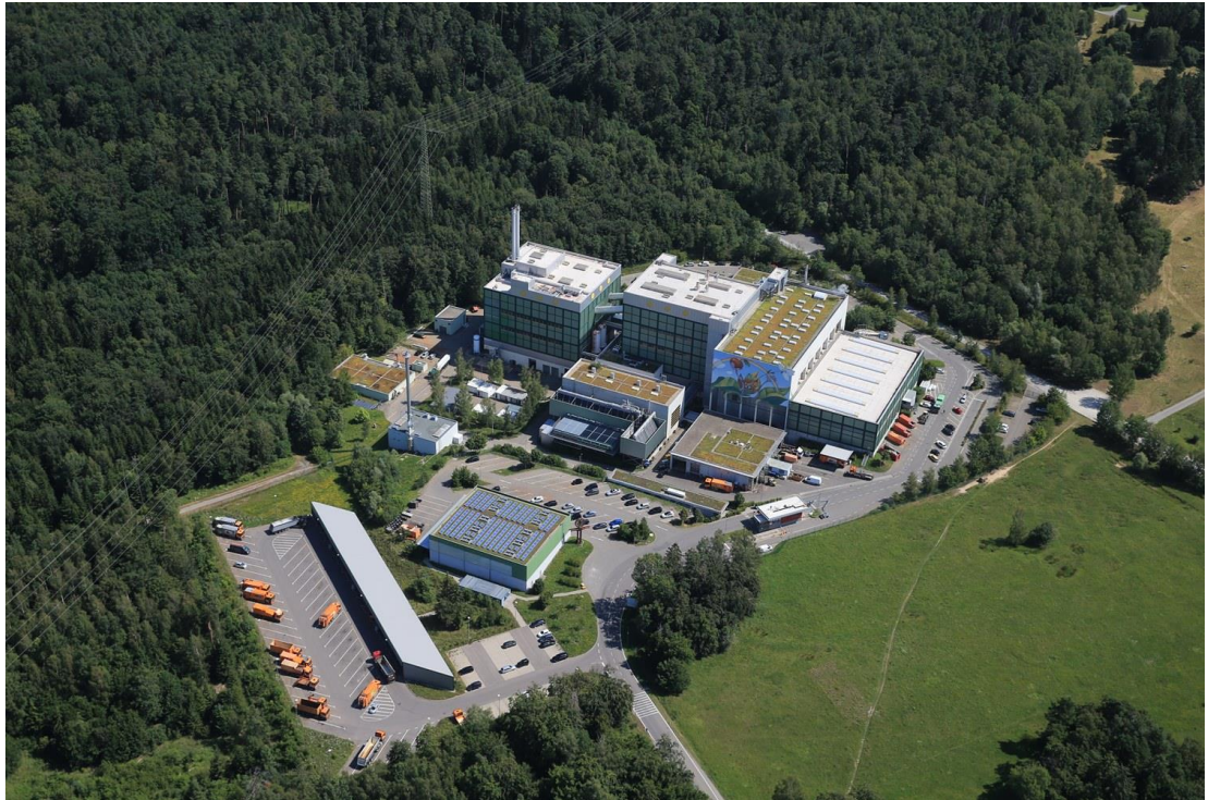
Abbildung 46. Ansicht von Südwest des Bestands-RMHKW [31]
