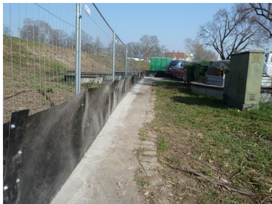
Abbildung 10: Beispielskizze eines Reptilienschutzzaunes (rechtes Bild). Auf dem linken Bild wurde der Zaun in einen Schlitz in der Gehwegdecke eingelassen.
