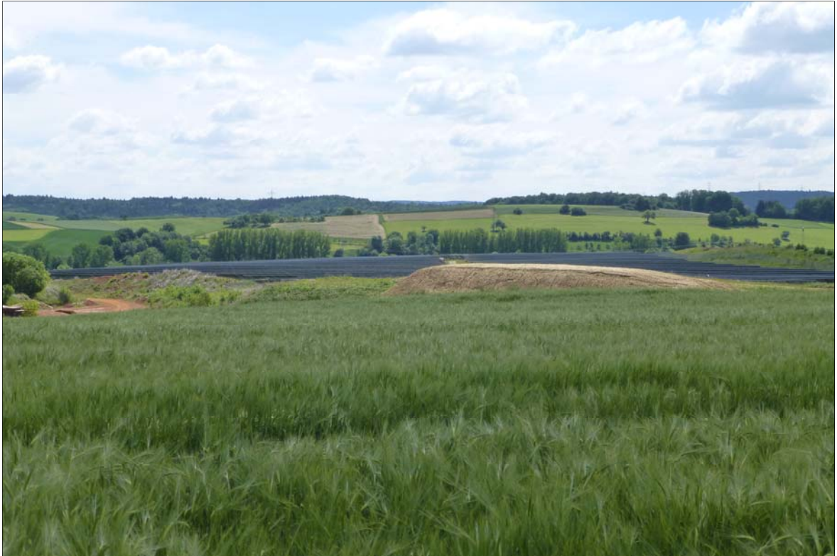
Abbildung 30: Blick vom westlich der Tongrube gelegenen Erweiterungsabschnitt auf die Solaranlage
