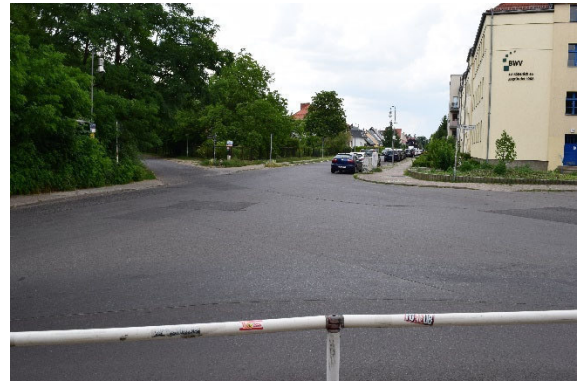
Knotenpunkt mit Blickrichtung Nord
