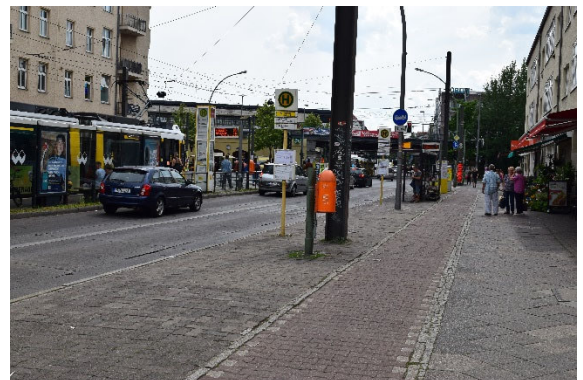
Haltestellenbereich S Köpenick Mahlsdorfer Str.
