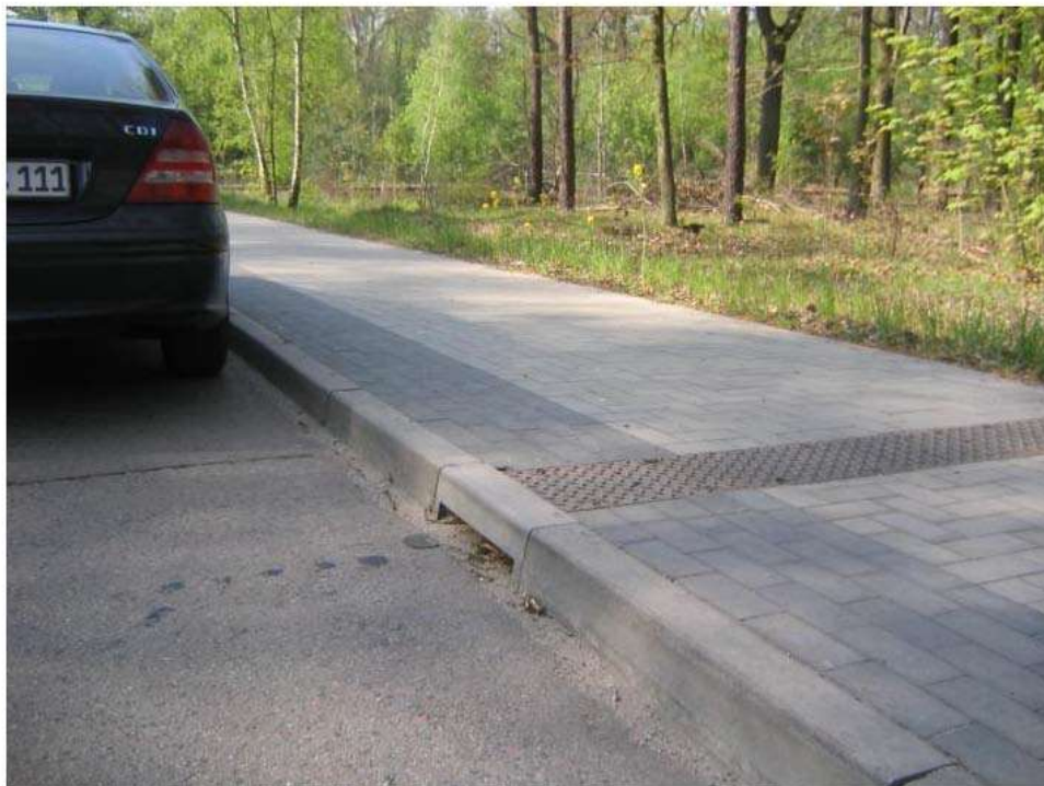
Abbildung 1: BIRCOprofil / Bordblock, Entwässerungsrinne mit seitlichem Bordeinlauf [11]
