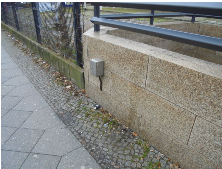
Abb. 13: Detailaufnahme von der Anschlussstelle Feuerwehr-Gebädefunk am Ausgang I/1
