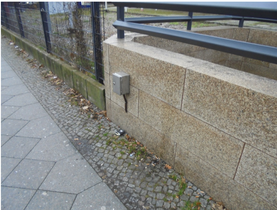
Abb. 15: Detailaufnahme von der Anschlussstelle Feuerwehr-Gebädefunk am Ausgang I/1
