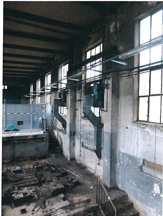
Abb. 5: Radschleifstand im Gebäude D
