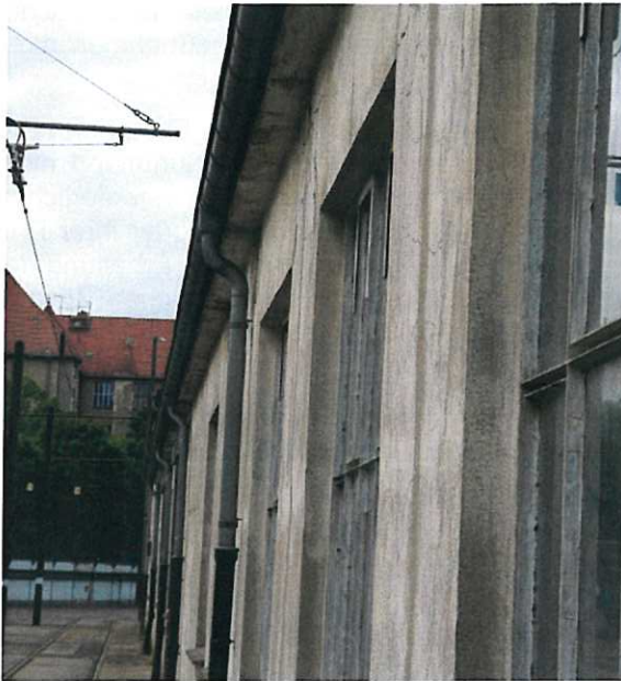
Abb. 2 Gebäude D mit angrenzender Abstellfläche
